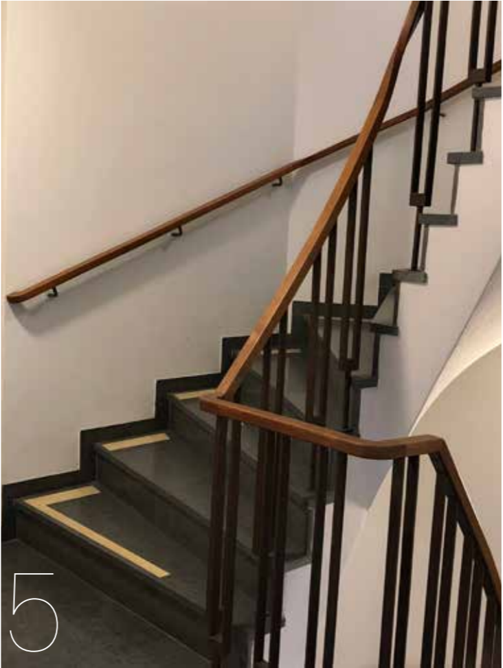
5. Del av ett av sekundärtrapphusen. Trots att det inte är ett huvudtrapphus är räckena ytterst medvetet utformade i smide och trä som kombinerat ger en smäcker lösning. 6. Handledare i trä i ett av sekundärtrapphusen. Kontrastmarkeringen på stegen i bakgrunden är senare tillkomna. 7. Detalj från trappa i huvudentrén. Omsorgen om detaljerna har varit stor. 8. Trappan i huvudentrén är utformad för att upplevas som svävande. De förändrade förhållandena i entréhallen förklarar det ursprungliga intrycket men trappan är än i dag ett karaktärsskapande inslag.
