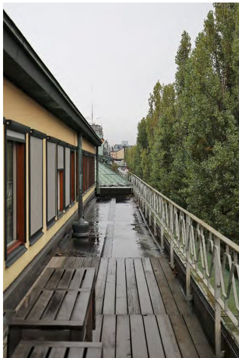
Till vänster: Altanen på den indragna, översta våningen utmed Luntmakargatan, med sitt karaktäristiska smidesräcke och kopparklädda takfot. Till höger: Samma altan, med närbild på de väl utformade och välproducerade byggnadsdetaljerna.
