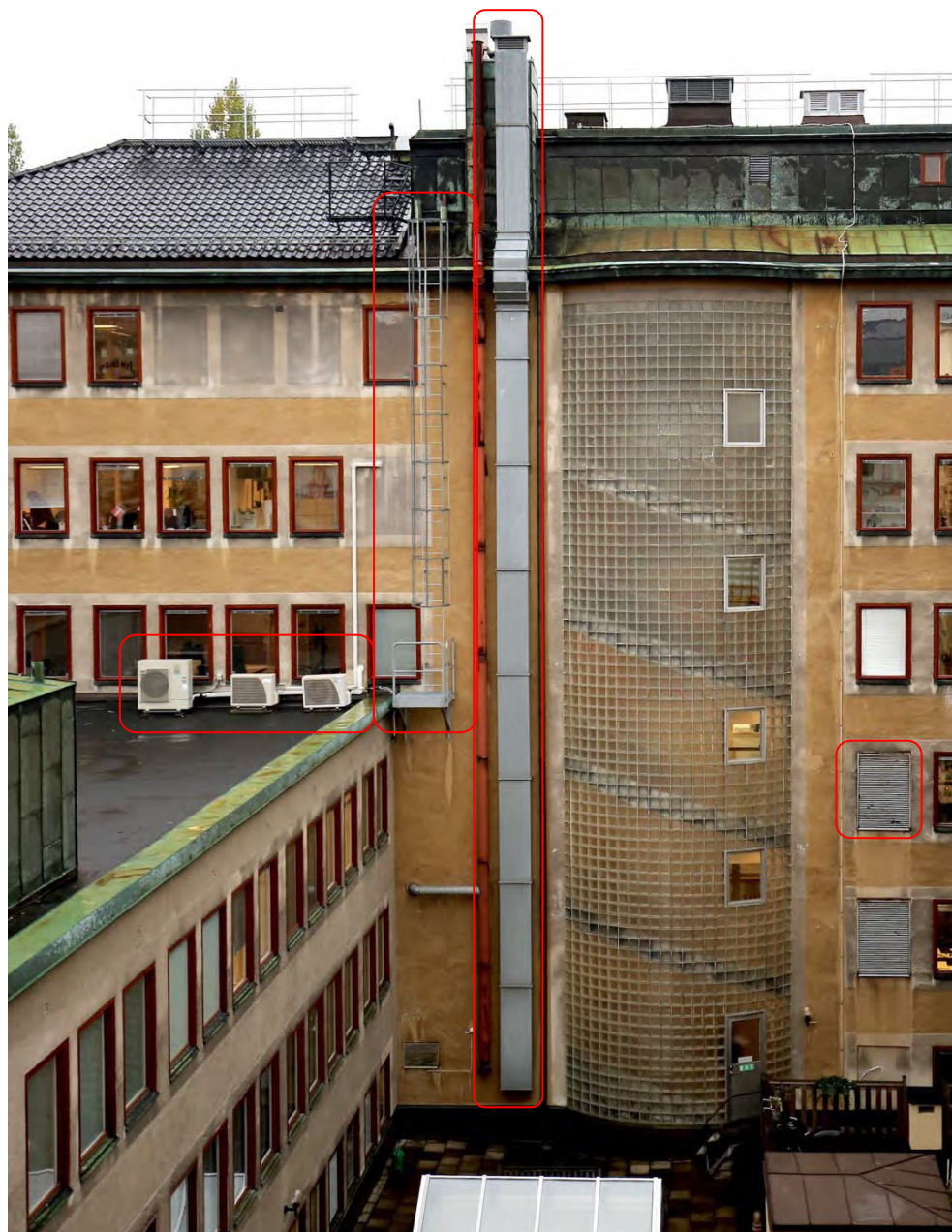
Fotografiet visar ett par exempel på några senare, exteriöra förändringar: En långsgående ventilationstrumma i rostfritt, igensatta fönster, brandtrappa och ventilationsaggregat.
