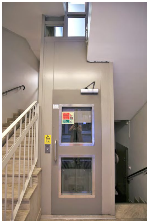
Till höger: Entrén mot Rosengatan. Dörrpartiet är ursprungligt. Till vänster: Innanför huvudentrén på Rosengatan står den hiss som installerades i mitten på 1980-talet. Trapploppet har sågats upp för att få plats med hisschaktet.
