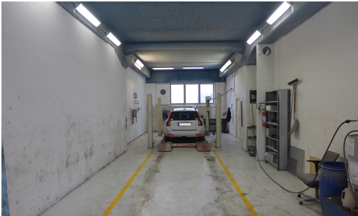
Lagerbyggnadens bottenvåning används idag som bilverkstad, med ett antal servicehallar av olika storlek. Lokalerna bevarar få eller inga ursprungliga detaljer men framhäver byggnadens brädgjutna stomme. Anläggningens industriella karaktär är därmed påtaglig.
