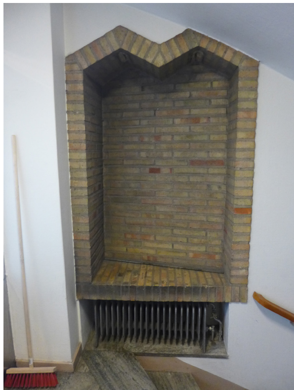
Trapphuset bevarar ett flertal ursprungliga detaljer så som dekorativa nischer i mur och med träomfattning, sektionsradiatorer, handledare i trä, smidesräcken och golv samt trappa klädd i kolmårdsmarmor.
