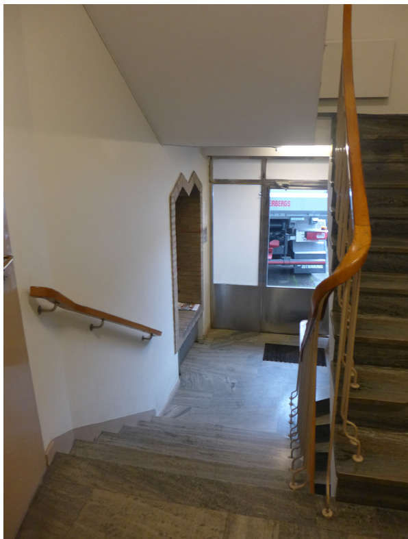
Trapphuset bevarar ett flertal ursprungliga detaljer så som dekorativa nischer i mur och med träomfattning, sektionsradiatorer, handledare i trä, smidesräcken och golv samt trappa klädd i kolmårdsmarmor.
