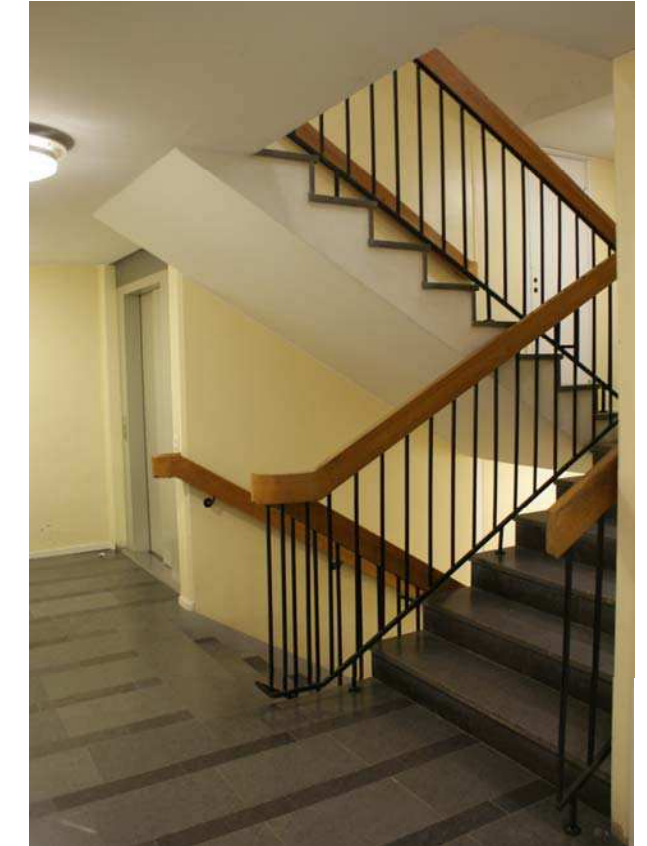
Trapphus i västra delen av byggnaden, med kalkstensgolv, slätputsade väggar och räcken av smide och trä.
