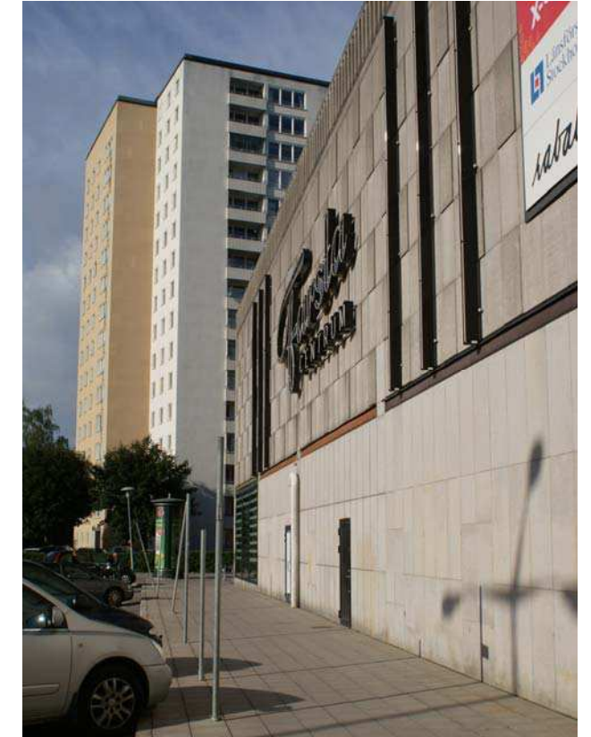
Fasad mot sydöst. Nedre delen är igensatt med stenskivor på 1990-talet. Äldre markisanordningar sitter kvar.
