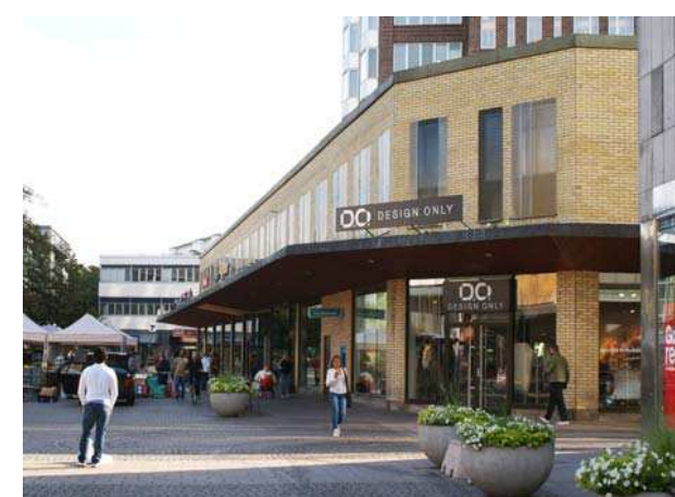
Övre planet inreddes till butiker 2010 och fönstren täcktes med perforerade plåtar.
