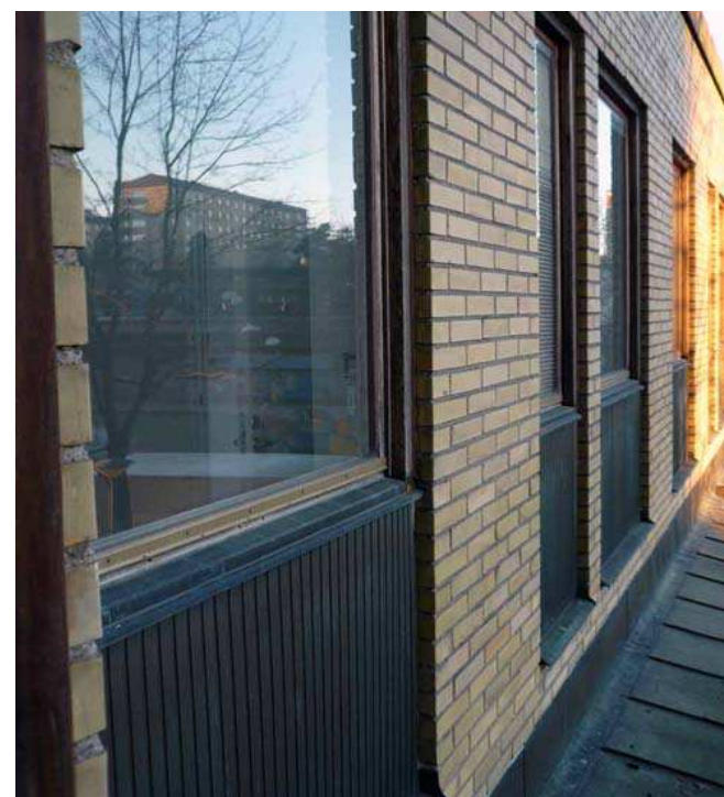
Detalj av tegelfasad och teakfönster med kopparplåt. Fönstren bevarades vid 2010 års ombyggnad
