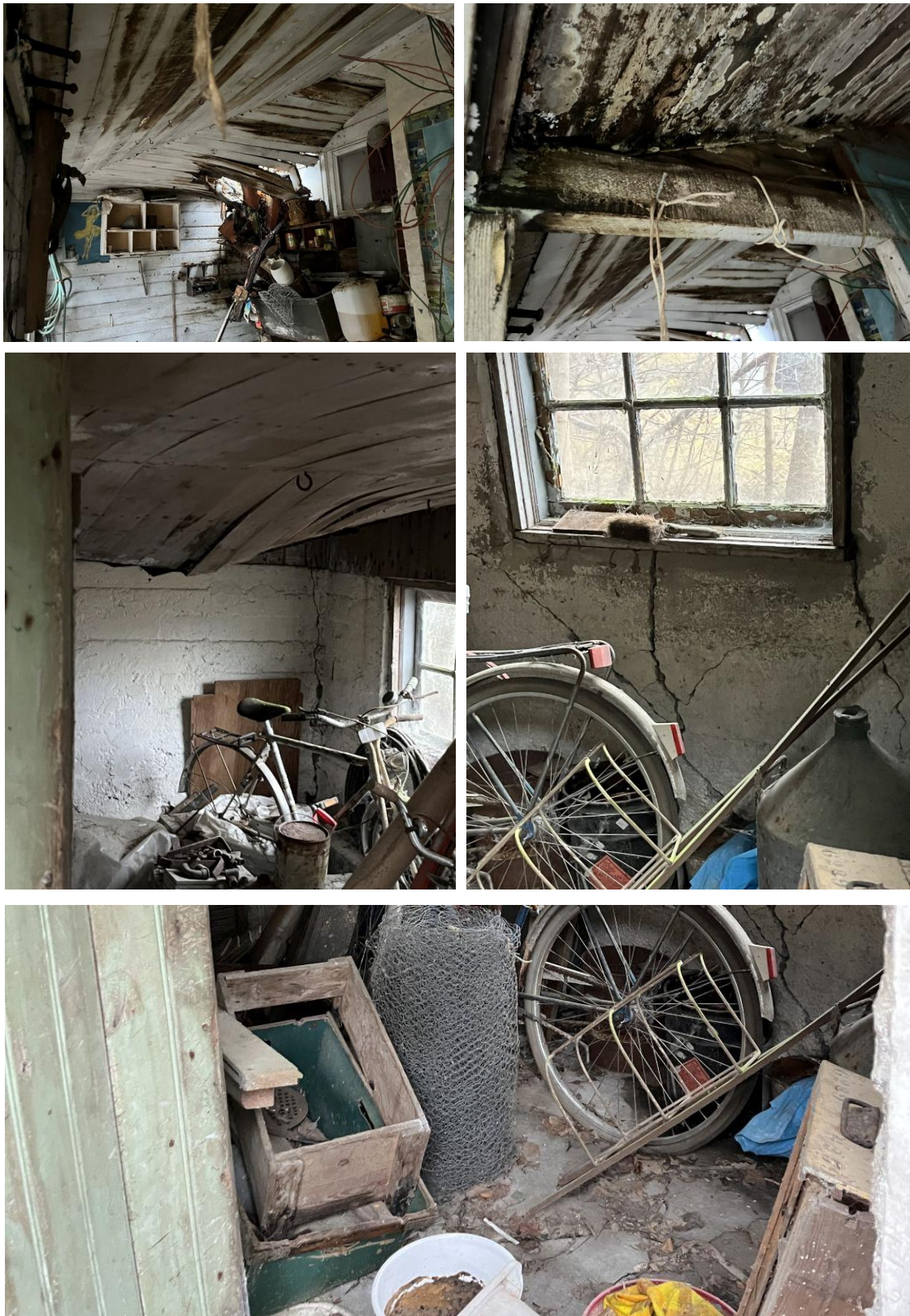
Figur 13. Interiören med ursprungliga ytskikt bevarade men i dåligt skick. Sprickor noteras i betonggolvet och sockeln.
