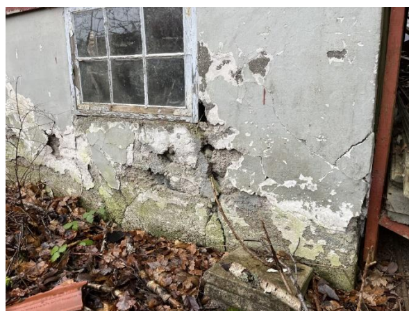
Figur 12. Kollaget visar exempel på dörr och fönsterutförande, panel och sockel. Utöver flagande färg förekommer rötskador med pågående biologisk nedbrytning samt strukturella skador i form av sprickbildning och materialbortfall.
