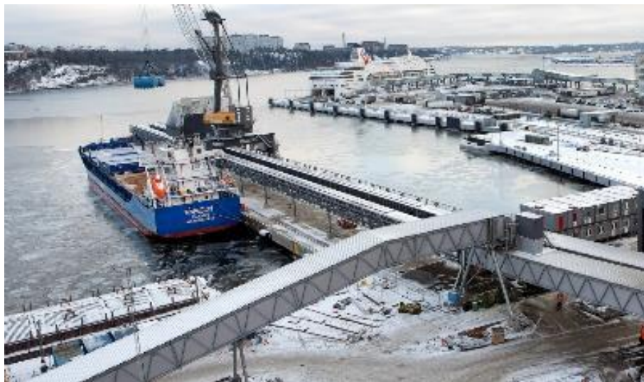
Figur 17. Lossning av flis med den nya kranen och piren vid Fortums biokraftvärmeverk i Värtan, från fartyget Emssun, längd 115 m, bredd 16 m, djupgående 6 m. (Foto Fortum)
