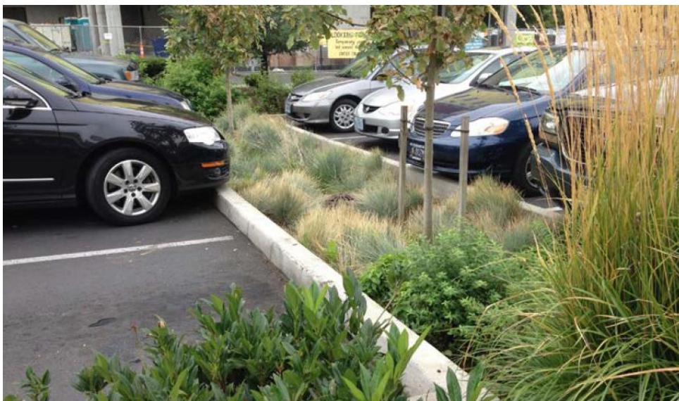
Figur 11 Exempel på nedsänkt växtbädd i parkering. I denna anläggning leds dagvattnet in i växtbädden via öppningar i kantstenen. Bild från Stockholm Vatten och Avfall (SVOA, 2019)
