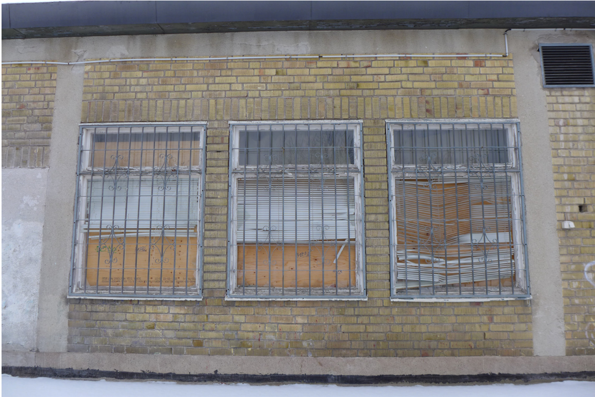
T h Stora fönster mot öster med öppningsbar övre del, tegel och putsdetaljer.
