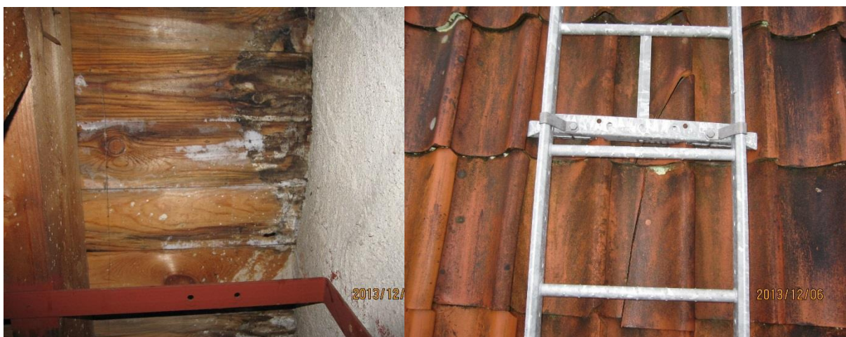
Skador omfattar bland annat sprickor i fasad och fönster, mögel och fuktskador samt spruckna och lösa pannor på John Nordströms väg 9
