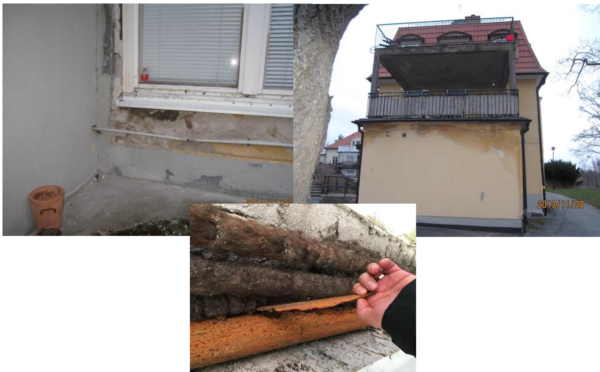
Skador och underhåll omfattar bland annat sprickor fasaden, mögel och rötskador på Carl Sebardts väg 6
