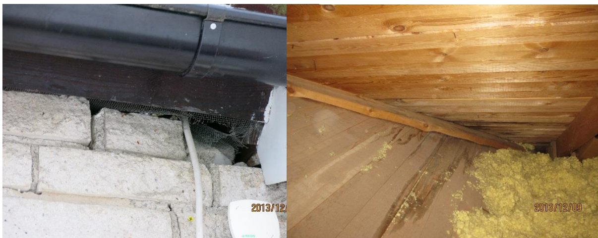
Skador omfattar bland annat håll i fasad och Missfärgning samt mögel på flertal ställen vid Thorsten Levenstams väg 93
