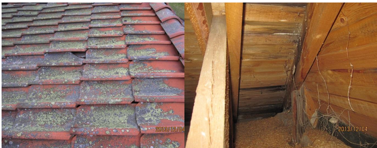
Skador omfattar bland annat spruckna takpannor, klätterväxter som har tagit sig i undervind, missfärgningar, läckage och röta i fasad och tak på Gustaf Ljunggrens väg 8
