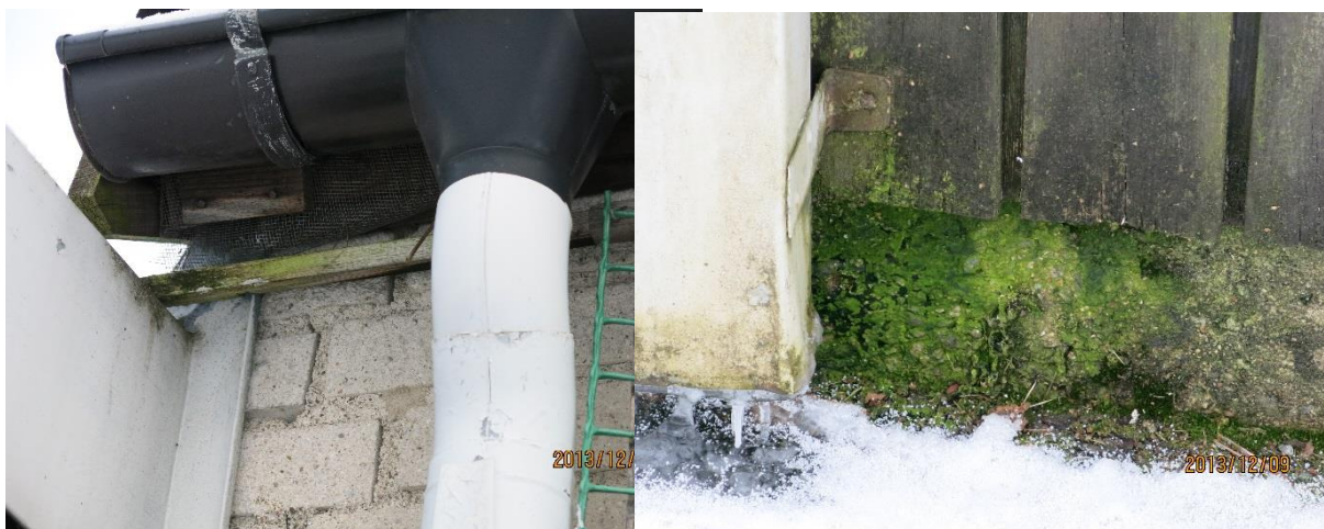
Skador omfattar bland annat sprickor i murbruk, läckage i tak, mögel, röta och missfärgningar i fasad och golv vid Thorsten Levenstams väg 82
