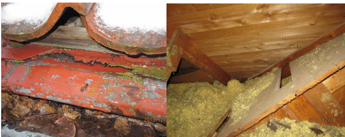
Skador omfattar bland annat lösa och spruckna pannor, felmonterad tak, läckage och fuktskador i fasad vid Thorsten Ulvenstams väg 20
