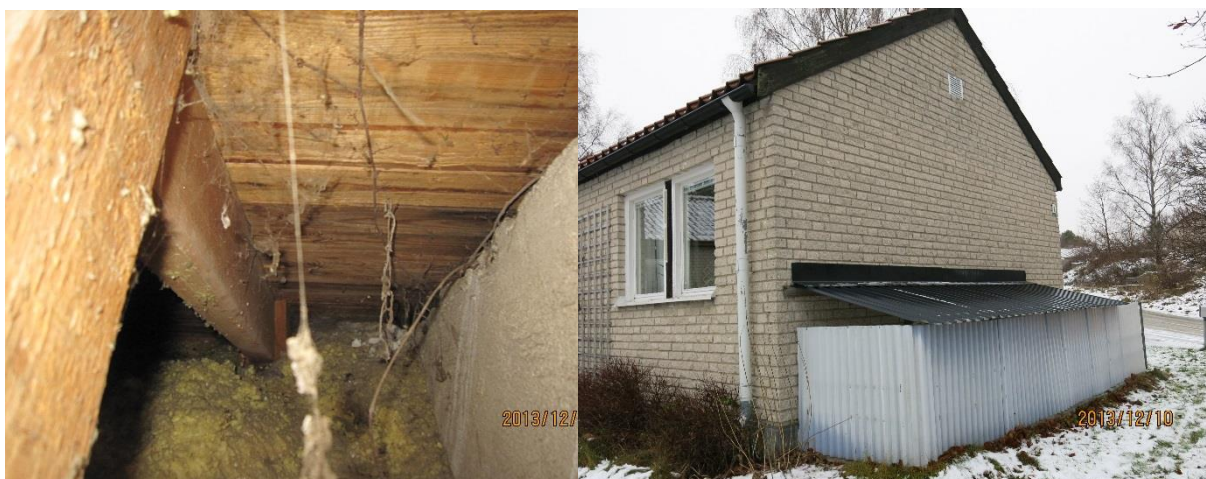
Skador omfattar bland annat lösa och spruckna pannor, felmonterad vind, röta och läckage i tak vid Thorsten Levenstams väg 1
