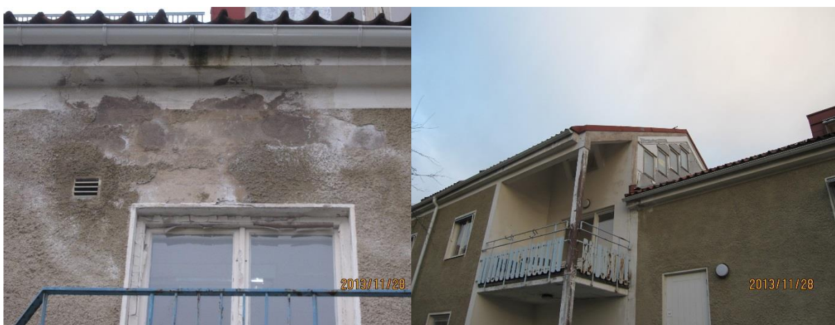
Skador och underhåll omfattar bland annat sprickor fasaden, mögel och rötskador på Carl Sebarths väg 6
