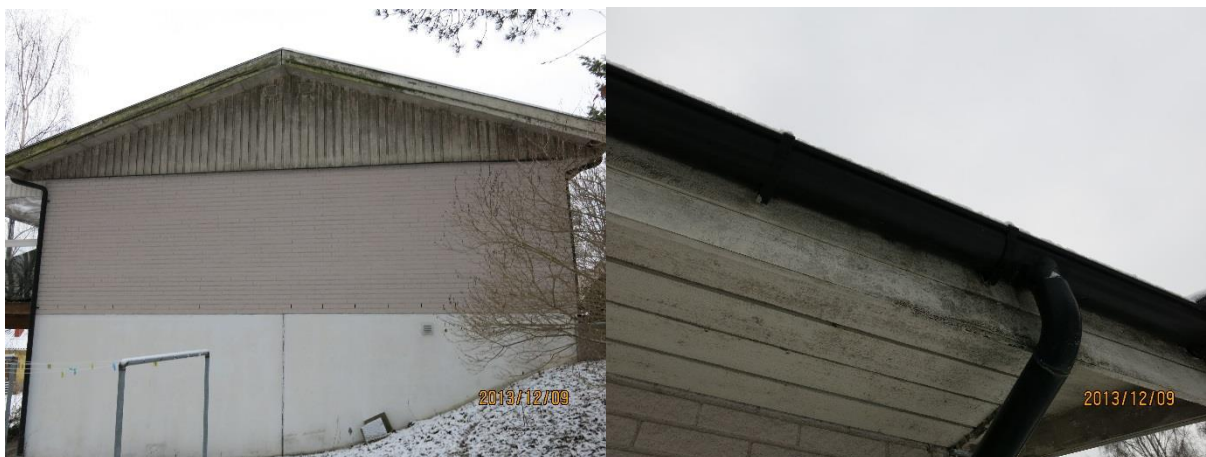
Skador inkluderar bland annat omfattande missfärgningar och röta i fasad och vind vid Thorsten Levenstams väg 97
