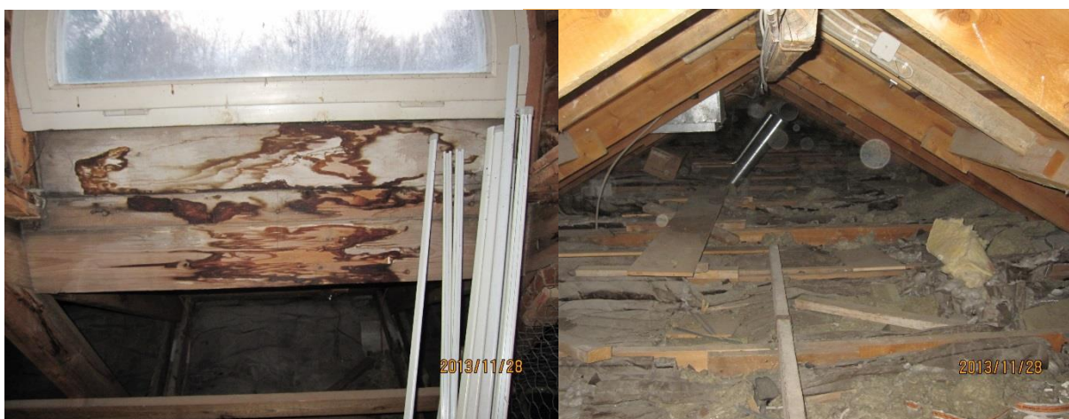
Skador och underhåll omfattar bland annat lösa och spruckna takpannor, rötskador och sprickor i fasad på Carl Sebarths väg 4a
