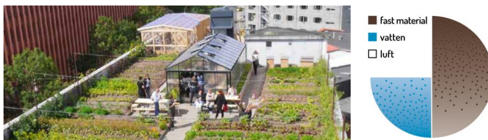
Figur 23. Odling på grönt tak samt optimal fördelning för uppbyggnad av växtbäddar. Bildkälla: Grönatakboken, 2017.
