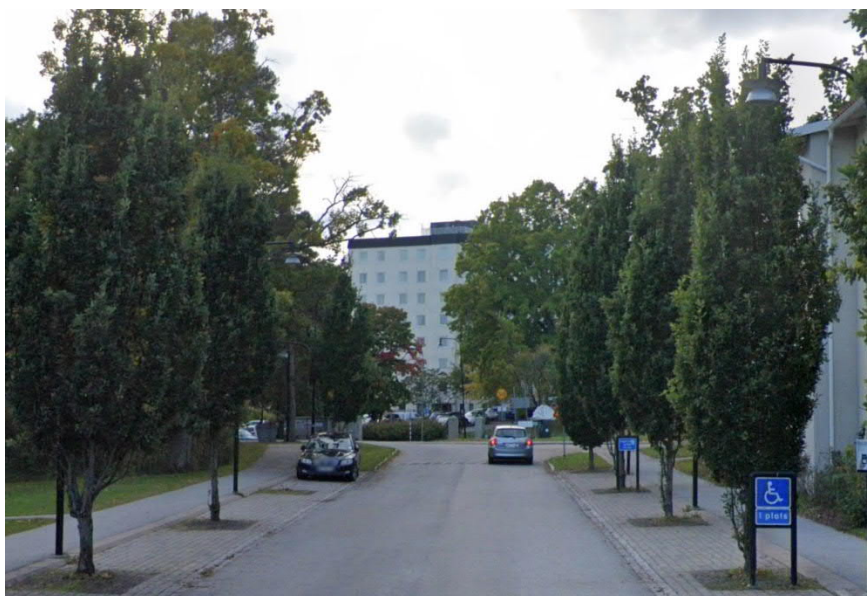
Figur 23. Befintlig utformning av Nils Lövgrens väg (från Google streetview) - dagvatten från vägytan når inte trädplanteringen.
