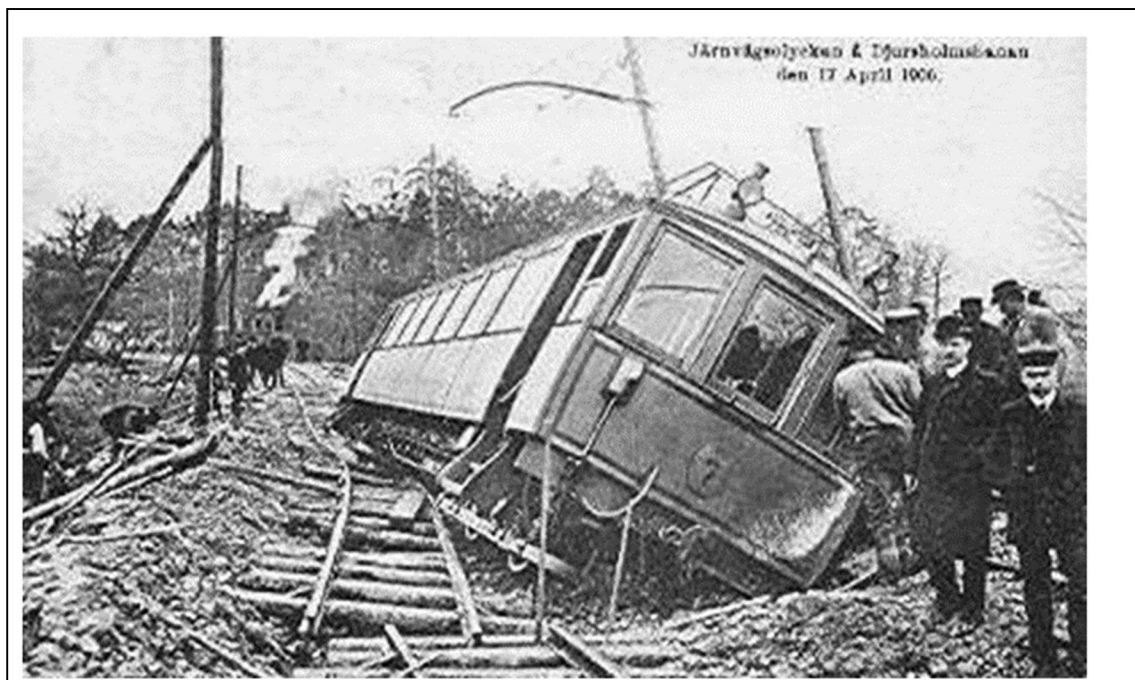
Figur 17. Urspårning på Djursholmsbanan den 17 April 1906. Trots att urspårningen var omfattande blev det primära skadeområdet endast begränsat till spårets omedelbara närhet.
