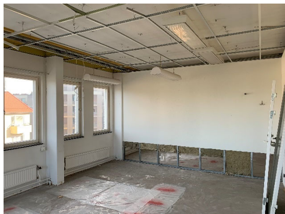
Foto t.h. Hus A, norra delen, delvis demonterad mellanvägg med stålreglar, rockwoolisolering och gipsskivor.
