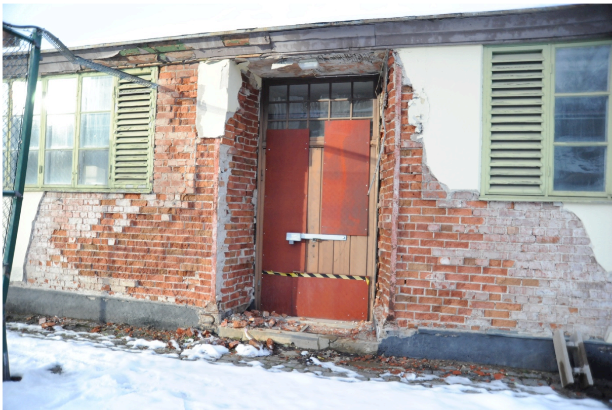
Frostskador i tegelstomme. Fasad mot söder.
