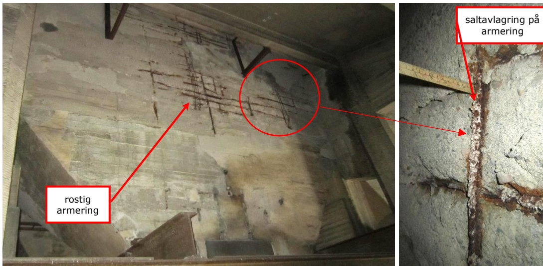
Kolficka F33 (se ritning). Salt/kalkufällningar på armeringen.
