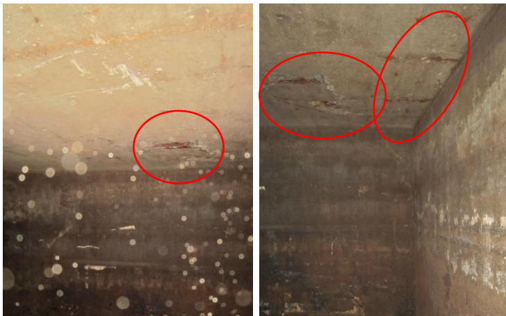
Kulvert med spjälkningar i bjälklagets undersida.
