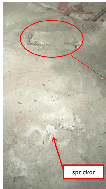
Spjälkningar i golvet i anslutning till brunn vid borrhål G5.
