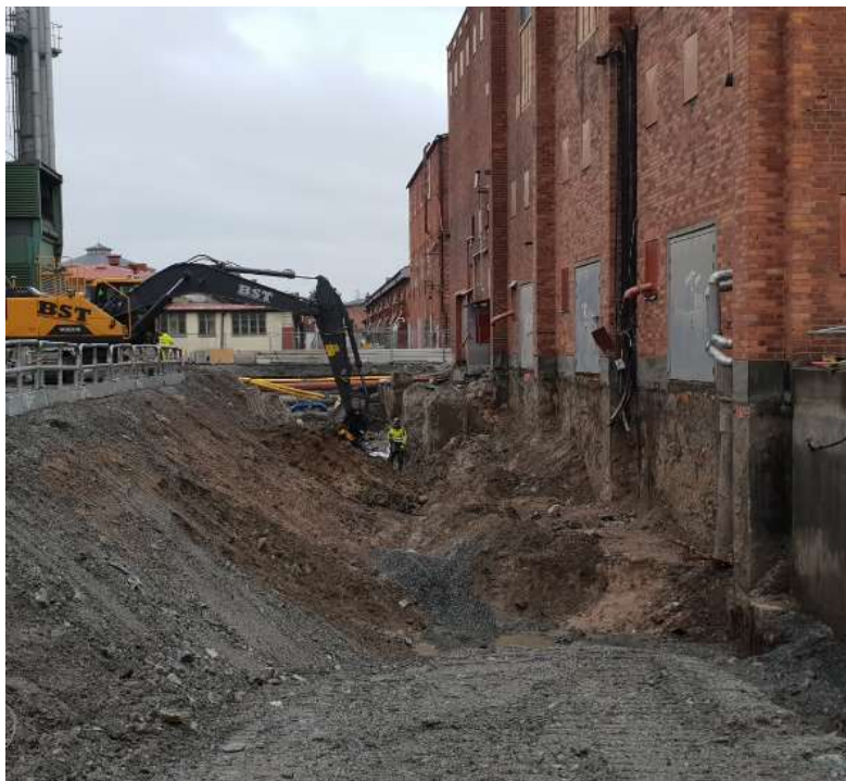
Sanering och avlägsnande av den gamla tjärledningen i samband med ledningsarbeten utmed Hus 21 i Gasverket Östra (2020).
