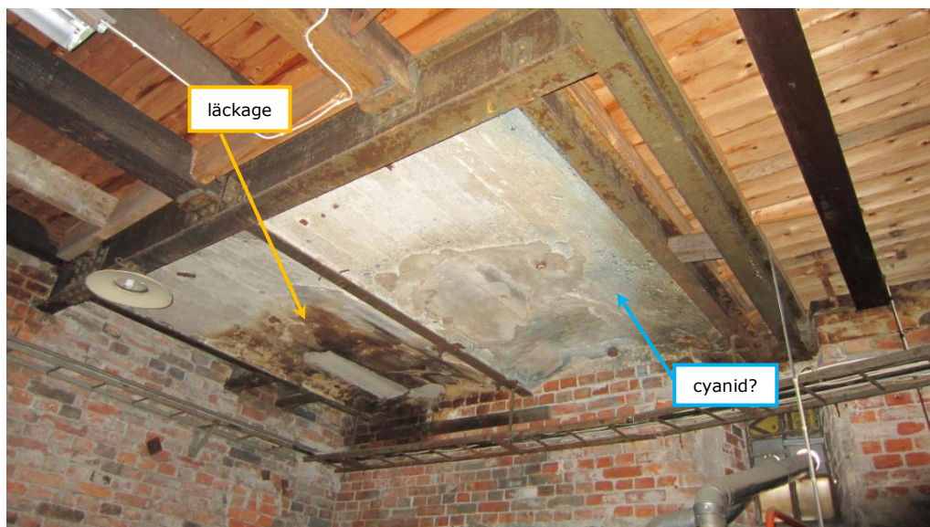
Betongvalv med troliga cyanidföroreningar samt läckage.
