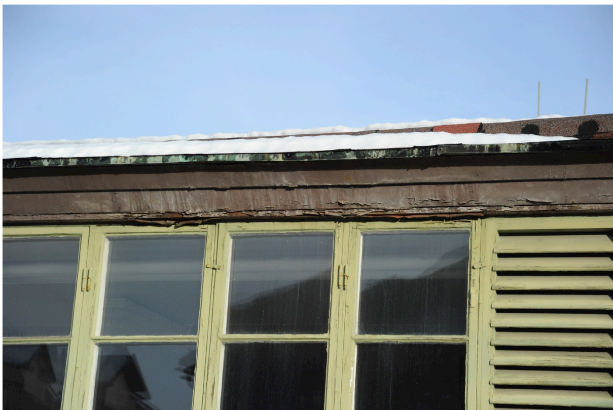
Fukt- och rötskadad träpanel i takfot.
