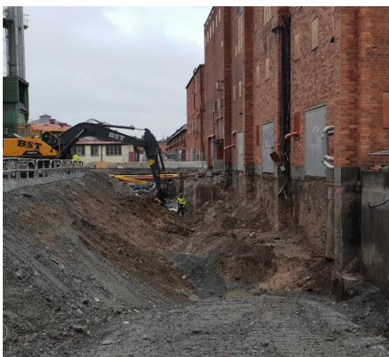
Bild 6: Sanering och avlägsnande av den gamla tjärledningen i samband med ledningsarbeten utmed Hus 21 i Gasverket Östra (2020).
