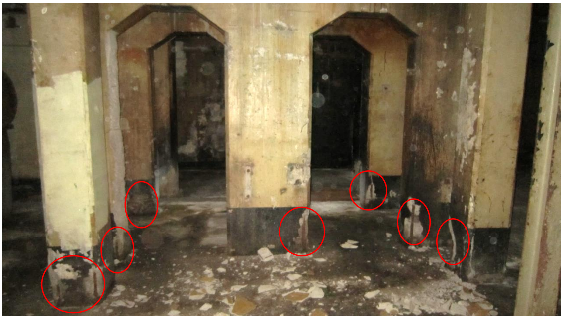
Spjälkning i samtliga pelarfötter (7st) i bilden.
