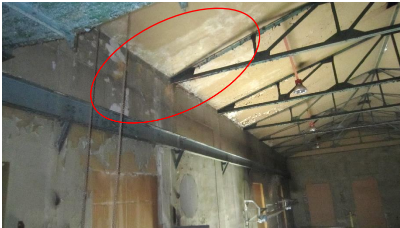
Fuktskador i tak och på väggar i hus 20.
