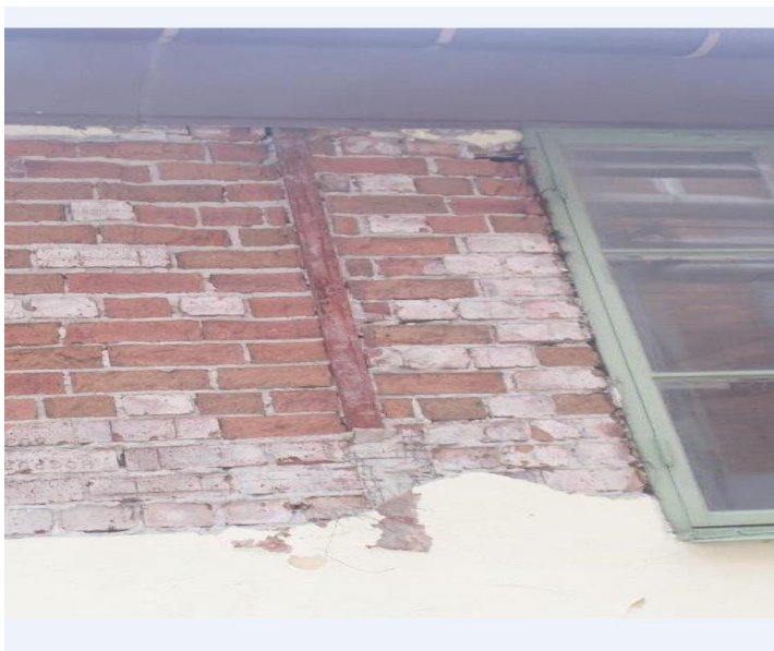
Bild 9. Norra fasaden 2014. Stålpelare ligger ytligt och utgör en köldbrygga.
