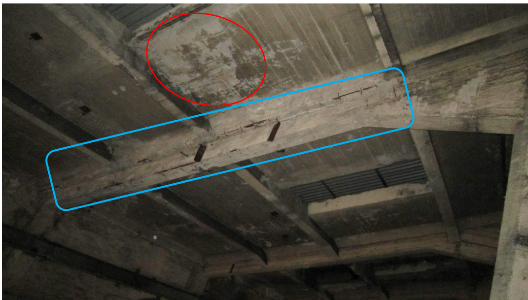
Skador i taket och på primärbalkar.
