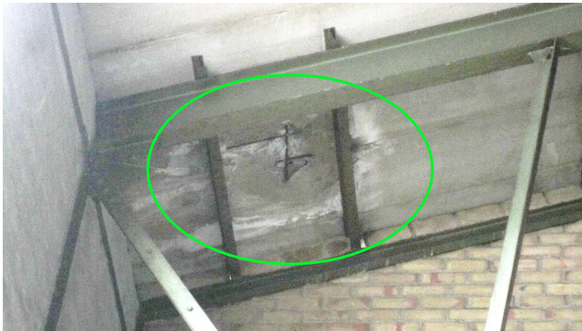
Läckage och spjälkning i taket.
