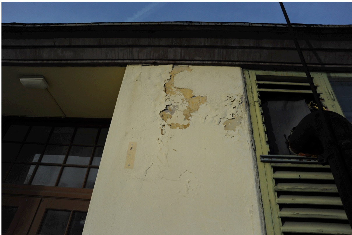
Läckage från tak med fuktutslag i puts. Sannolika skador i underliggande tegelstomme.
