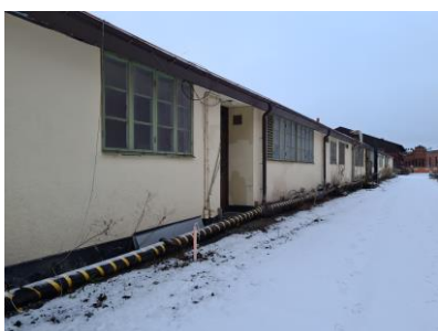
Stora delar av fasaden är i mycket dåligt skick. Se även foton från entréerna nedan.
