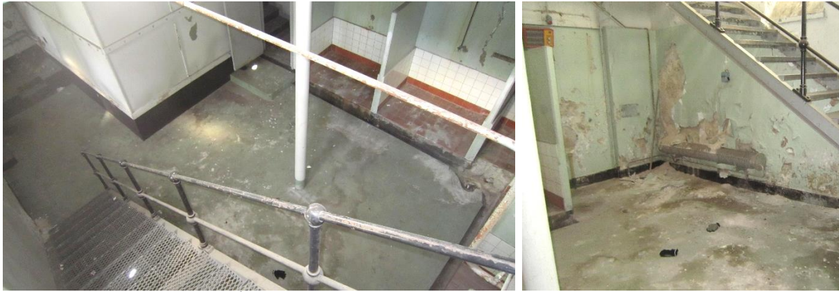
Översikt duschrum och dåliga ytskikt med fuktskadad puts.
