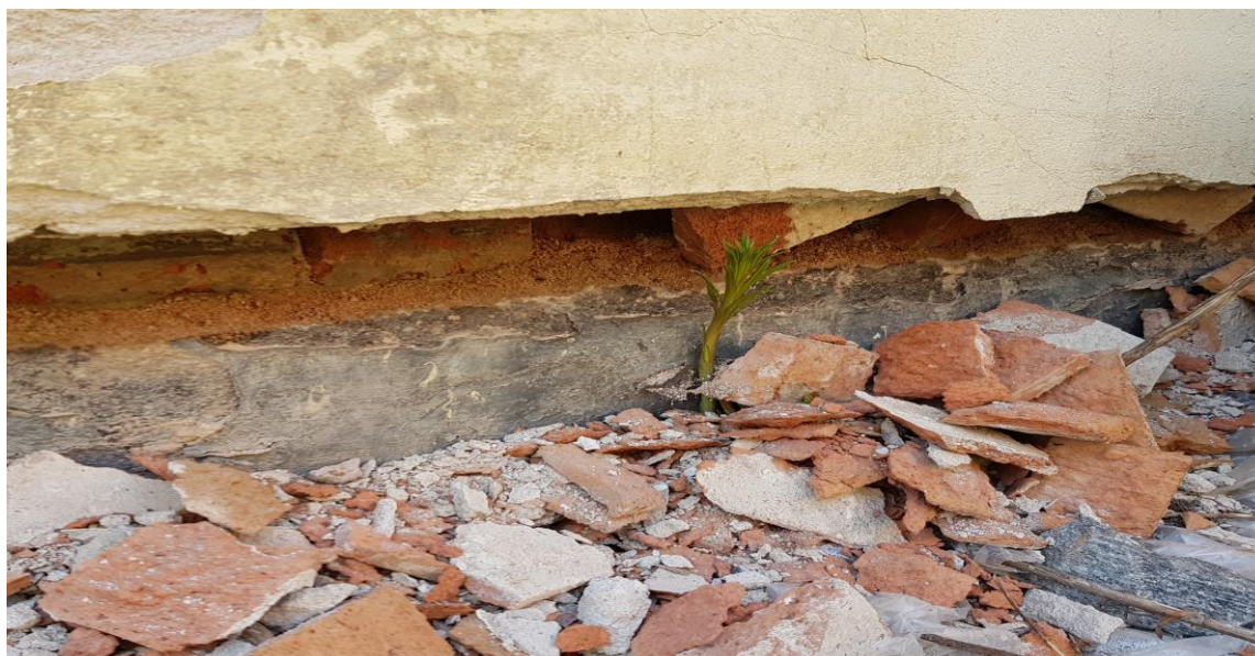
Bild 8. Samma fasad som på bild 5 från 2019. Teglet är genomblött och sönderfruset i maj 2019
