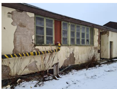
Stora delar av fasaden är i mycket dåligt skick. Se även foton från entréerna nedan.
