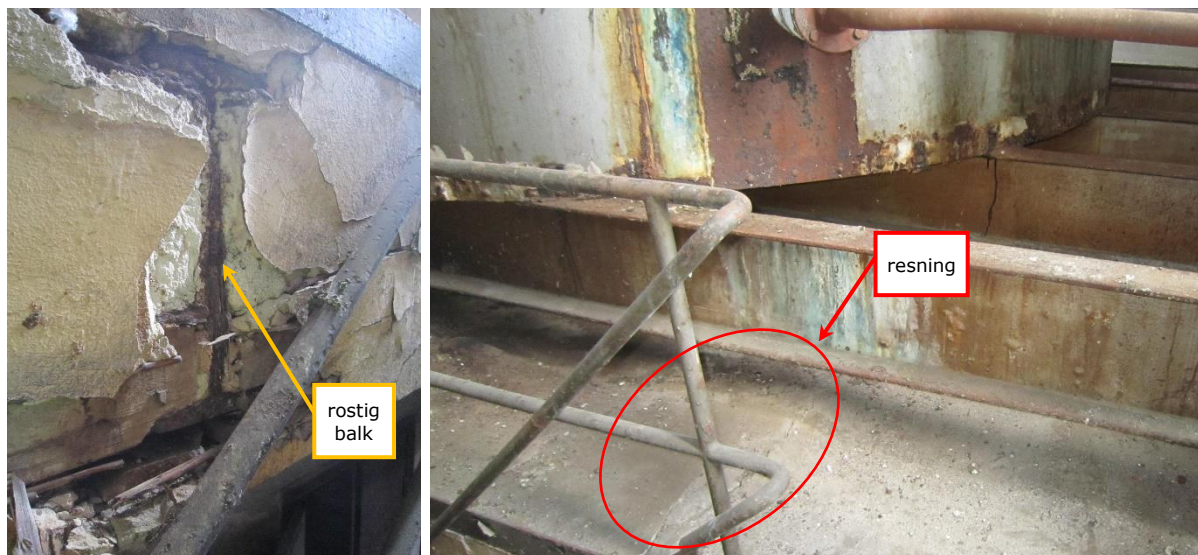
Rostig balk i bjälklagskanten. Resning i golvets ovansida.
