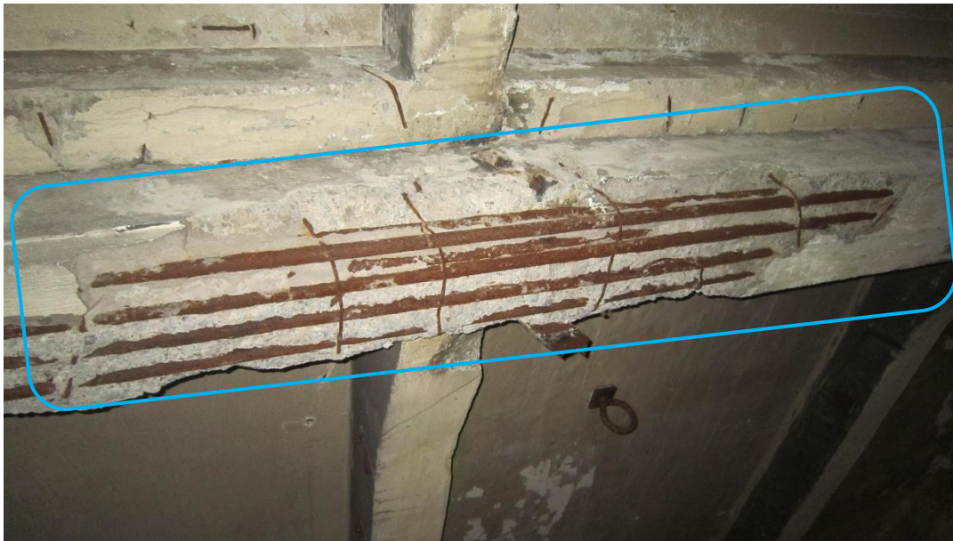
Primärbalk i taket med spjälkning.
