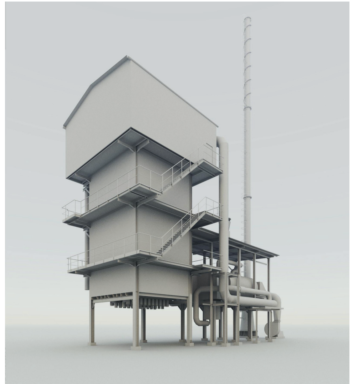
Visualisering av 3D-modell som visar spaltgasverkets huvudsakliga delar utan de borttagna delarna
