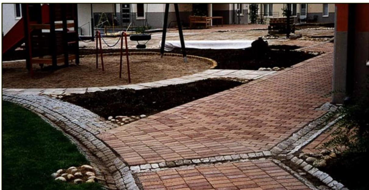
Figur 6-3. Exempel på avledning av takvatten via rännor anlagda med gatsten (Källa: Stockholm Vatten AB, n.d.).
