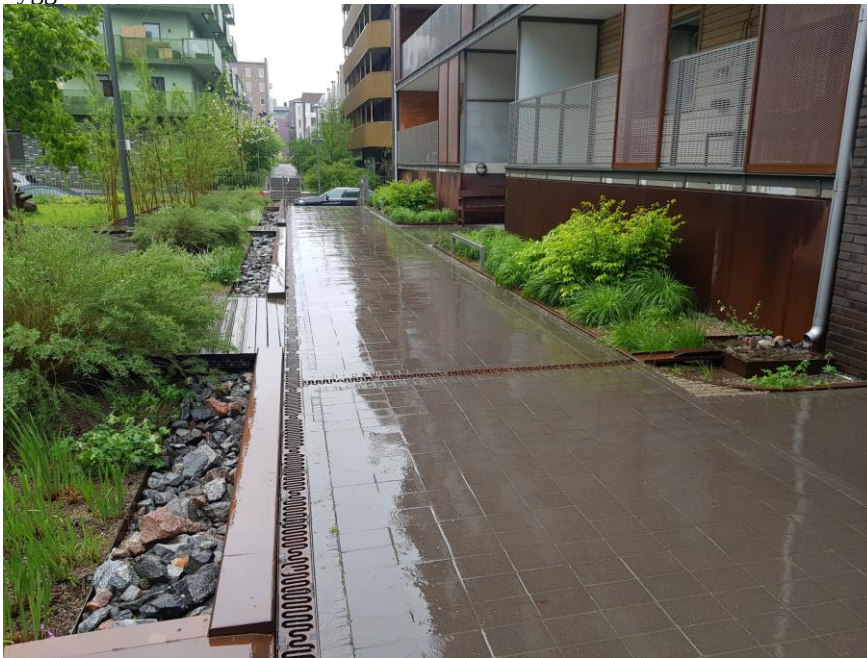
Figur 13. Ex. på utkastare från stuprör med rännalar till växtbädd.
