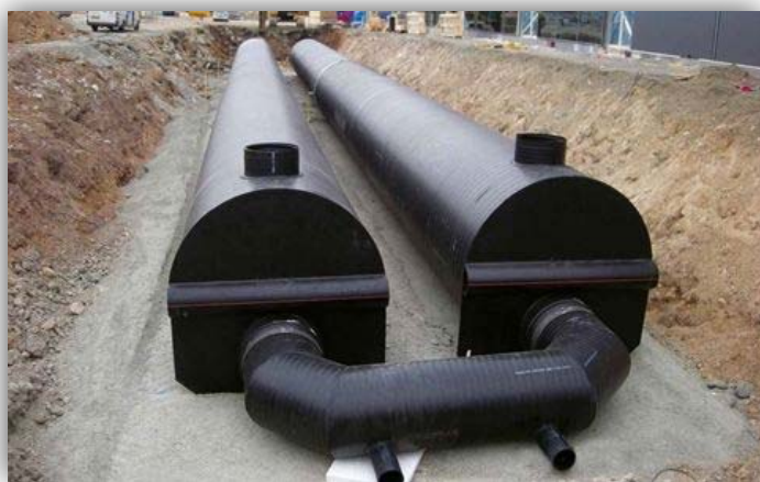
Bild 13. Exempel på rörmagasin för fördröjning av dagvatten. Kan anläggas under körbara ytor (Uponor 2021-04-30)
