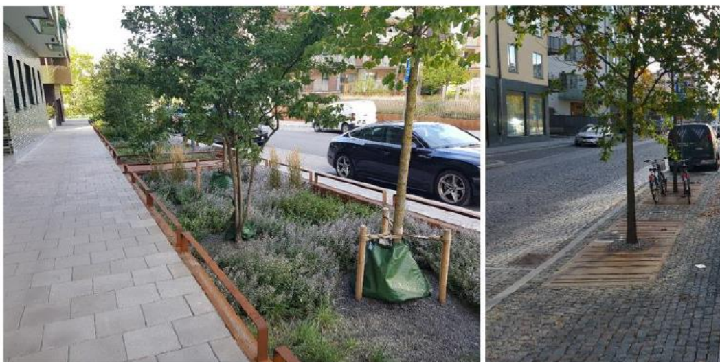
Exempel på skelettjordar och nedsänkta växtbäddar som det kan se ut längs Linta gårdsväg, DB1 används på bilden till vänster och DB4 på bilden till höger.
