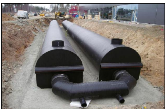
Figur 9-18. Fördröjningsmagasin i plast, i form av rörmagasin (vänster) och plastkassetter (höger).
