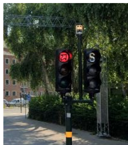
Figur 7. Exempel på signalreglering med separat bussignal vid Västerbroplan.
