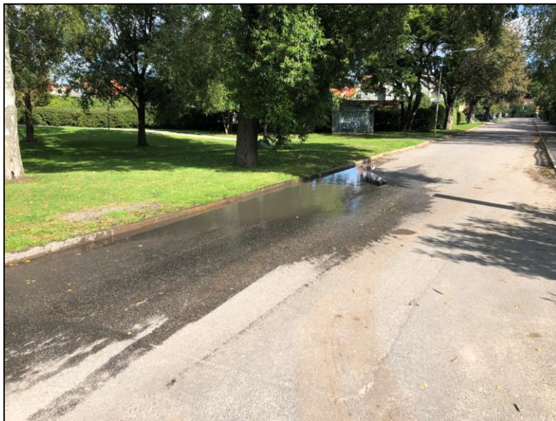
Figur 7. Foto taget 2019-09-12 på Ålandsvägen i nordlig riktning som visar att dagvatten kan ansamlas längs med gatans kantsten. Planområdet till höger i bild.
