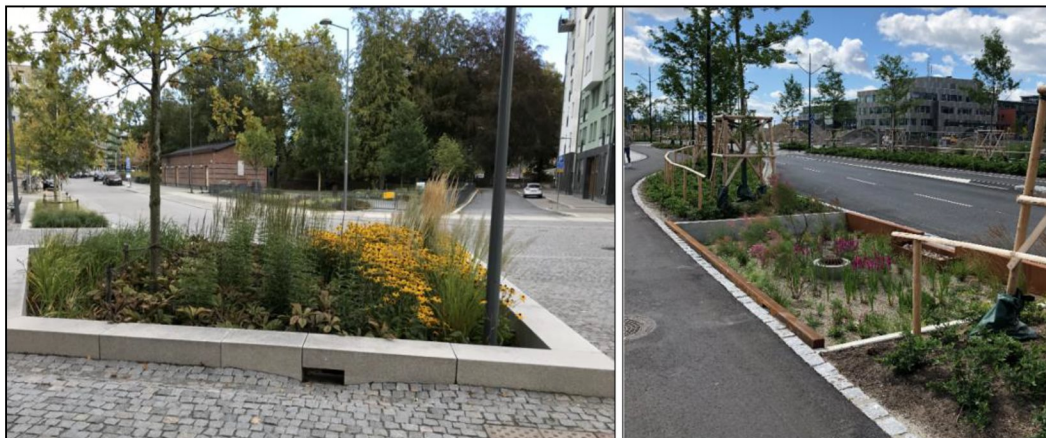
Figur 10. Exempel på nedsänkta regnbäddar (Foton: Norconsult)
