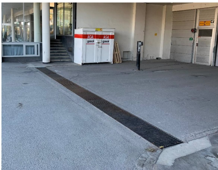
Figur 17. Större dagvattenränna.
