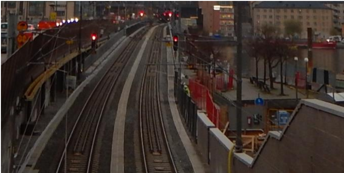
Figur 18: Urspårningsräl och kantbalk på Getingmidjans bro kan minska sannolikheten för att ett tåg som spårar ur lämnar spårområdet.
