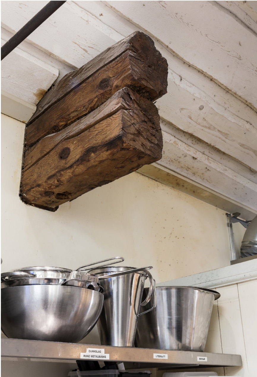
Bevarad rest av timrad mellanvägg. ME SSM_10036308.
