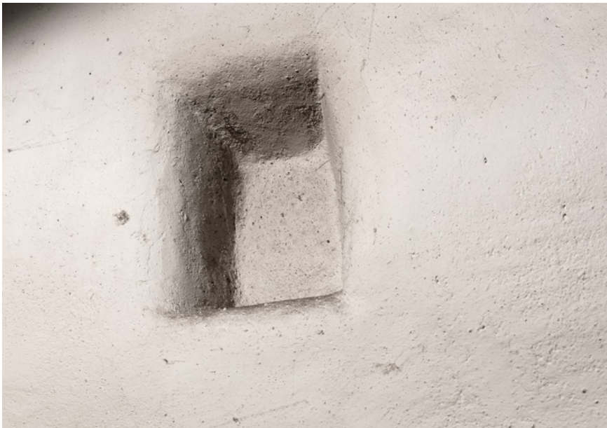
Detaljbild på upplagshål. Den tjocka lerkliningen är sentida, men hålet avspeg- lar en uthuggning i bakom- liggande timmerstomme. ME SSM_10036294.
