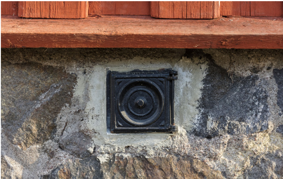
Byggnadens gråstenssockel fogades med cement under 1900-talet. Vid den senaste ombyggnaden installerades ventiler av gammal typ. ME SSM_10036349.
