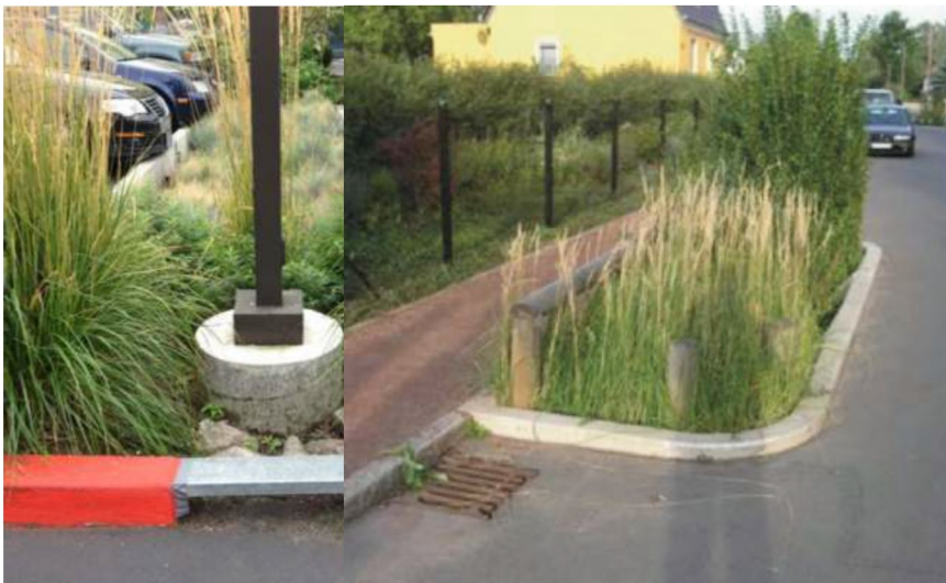
Figur 6. Exempel på lösningar för hur vatten ska ledas till växtbädd från de hårdgjorda ytorna kan utformas. Antingen med öppning i kantsten runt växtbädd (till höger) eller genom brunn vars utlopp ligger i växtbädd (till vänster). Foto: WRS
