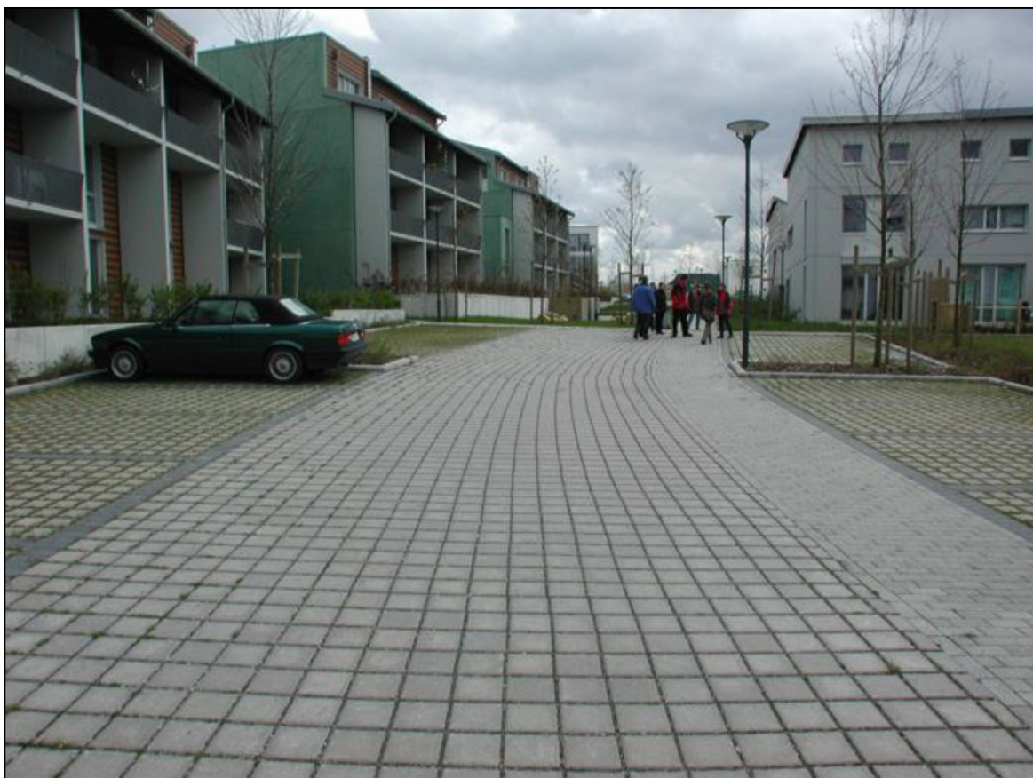
Figur 15. Parkering och gata med genomsläpplig beläggning (Foto: Norconsult).
