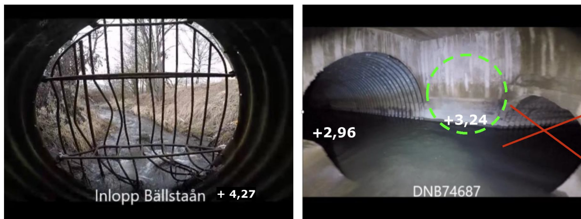
Figur 4 Utdrag ur filmning av kulverten. T.v. Bällstaåns inlopp i kulverten. T.h. brunn där den nya D2000-ledningen (grön streckad cirkel) möter Bällstaån. Gammalt påslag igensatt (rött kryss).
