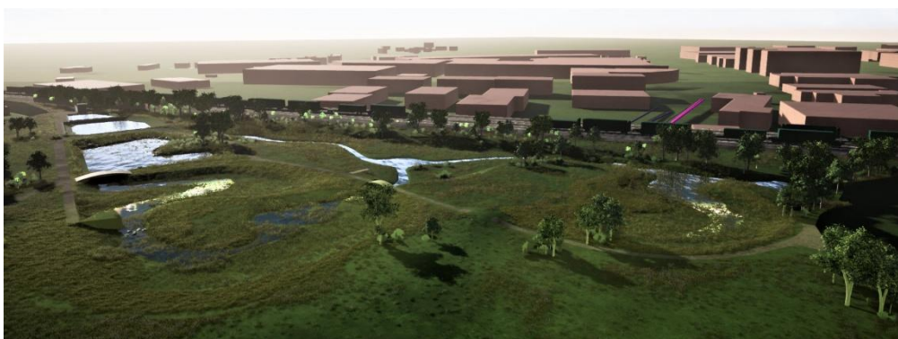
Fig 1. Låga nivåer, Bällstaån rinner i å-fåran. Våtmarken fungerar som poleringssteg för dagvattenreningsanläggningen. Visualisering från 3D modell: Gabriel Lindqvist
