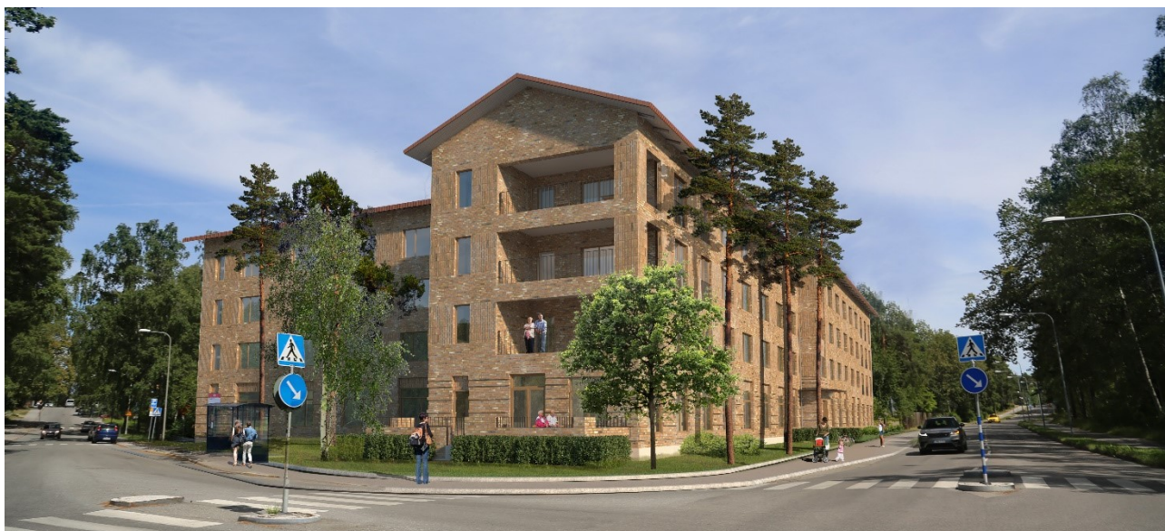
Vy från korsningen mellan Västerled och Abrahamsbergsvägen. Byggnaden bör ha en tunn utstickande takfot. Sockeln ska markeras i fasad. Sockel föreslås markeras med tegeldetaljer, murning som skiljer sig från den övriga fasadens murning samt markering kring fönster. Byggnaden har en generell variation i teglets bränning/färg. (Åwl arkitekter).
