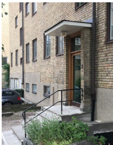
Vy från korsningen mellan Västerled och Abrahamsbergsvägen. Byggnaden bör ha en tunn utstickande takfot. Sockeln ska markeras i fasad. Sockel föreslås markeras med tegeldetaljer, murning som skiljer sig från den övriga fasadens murning samt markering kring fönster. Byggnaden har en generell variation i teglets bränning/färg. (Åwl arkitekter).
