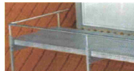
Typ bild- Räddningsplattform/ stigbrygga Räckeshöjd 150 mm Storlek anpassad efter bredd på takkupa
