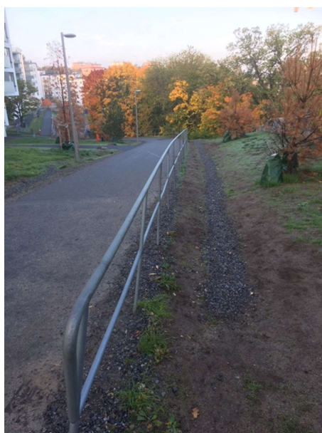
Figur 8. Exempel på dikesutformning längs huskropparna där uteplats finns.
