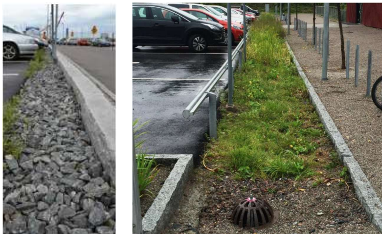
Figur 11 Exempel på stramare, mindre platskrävande fördröjning för dagvatten från parkeringsytor.
