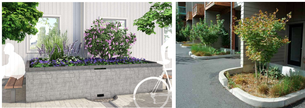
Figur 6 Exempel på växtbäddar för dagvattenhantering tak.
