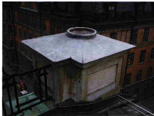
BEFINTLIG SKORSTEN, ÖPPEN KANALMYNNING SOM TÄCKS ÖVER
