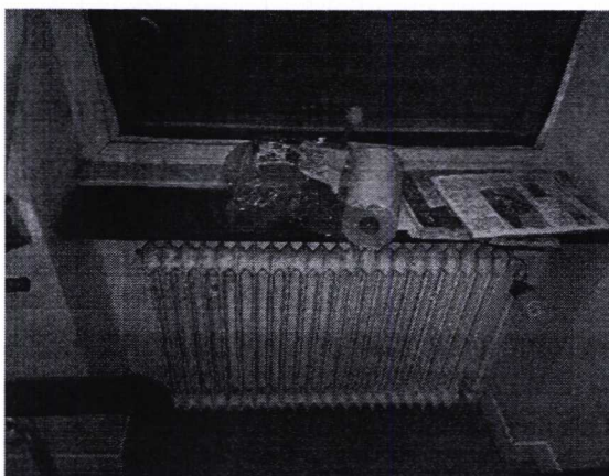
Foto 1. Svarta fönsterbänkar som bedöms innehålla asbest.
