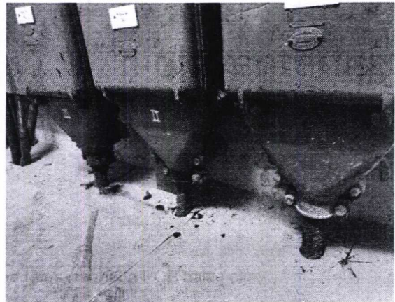
Foto 6. Äldre elkablar som bedöms vara oljefyllda där oljan riskerar att innehålla PCB.
