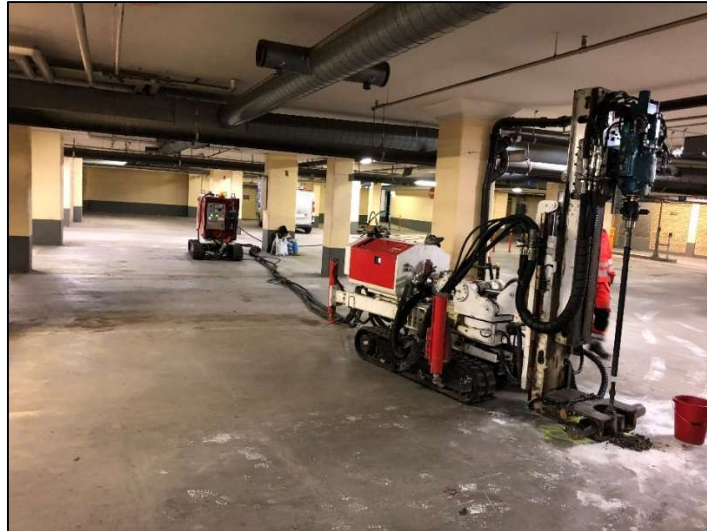
Figur 1. Markprovtagning och installation av grundvattenrör utfördes med eldriven borrhandsvagn "källarmus" utrustad med skruvborr.
