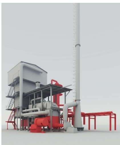
De delar av spaltugnstornet som föreslås tas bort har markerats i rött. Bilderna till höger visar spaltugnstornet när delarna har tagits bort.
