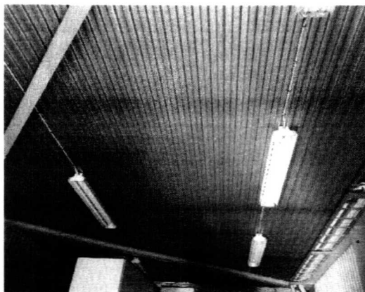
Foto 3. Kondensatorer till lysrörsarmaturer som bedöms kunna innehålla PCB haltig olja.
