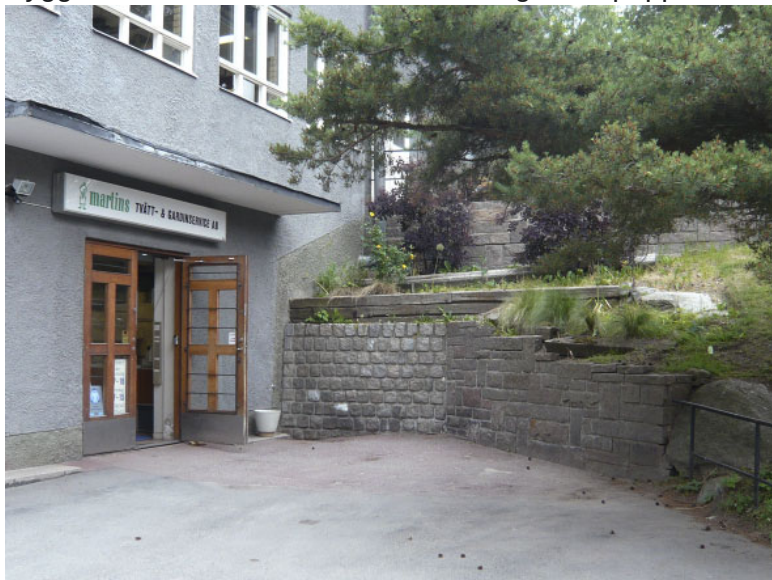
Den nedre souterrängvåningen bevarar pardörrar av lackad ek med glasade fyllningar. Notera markplaneringen med de bearbetade naturstensmurarna.
