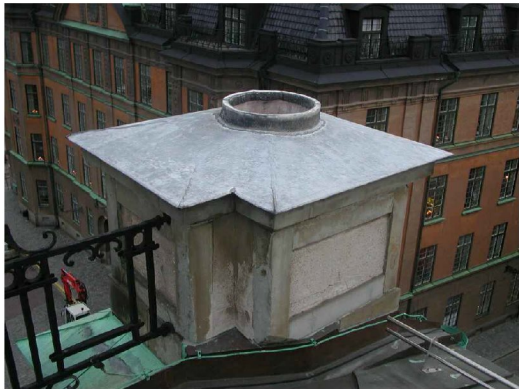
BEFINTLIG SKORSTEN, ÖPPEN KANALMYNNING SOM TÄCKS ÖVER
