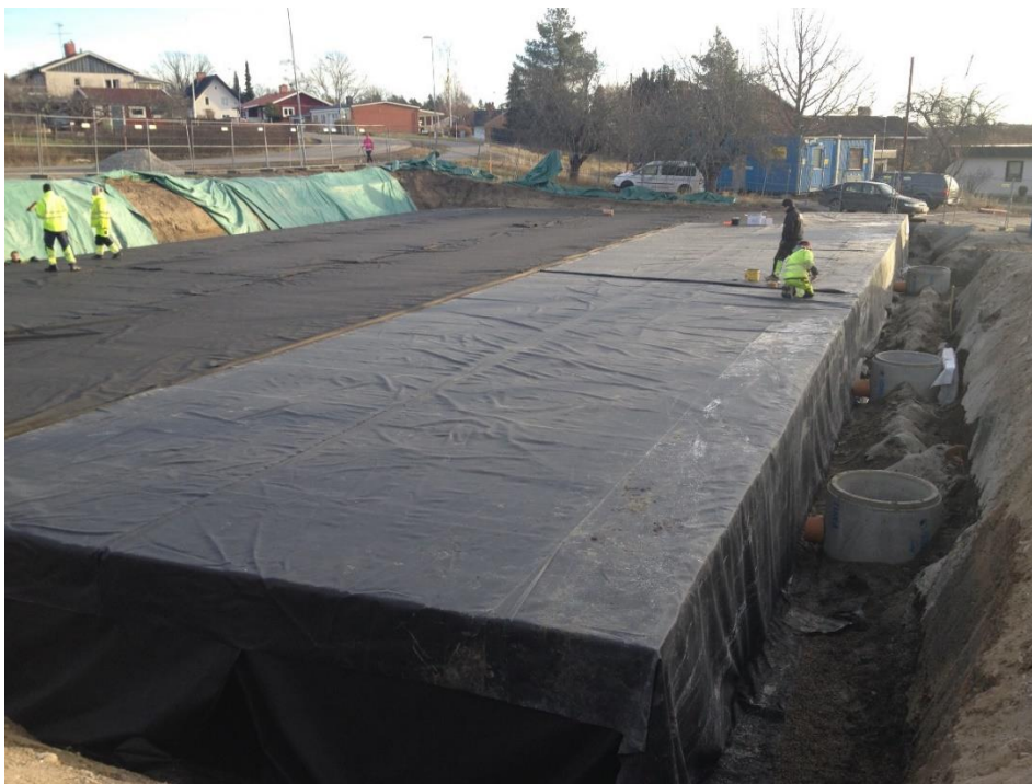
Figur 17 Anläggning av fördröjningsmagasin med plastkassetter
