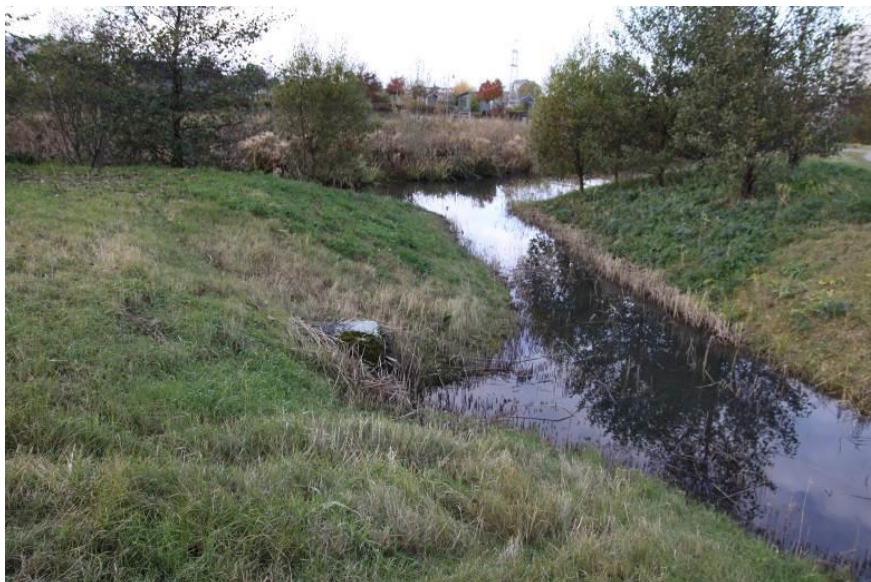
Figur 37. Dike för dagvattenavledning, Årstafältet Stockholm. Foto: Daniel Larsson.
