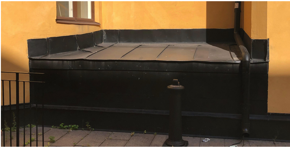
BILD, INBYGGNAD AV VENT. KANAL
