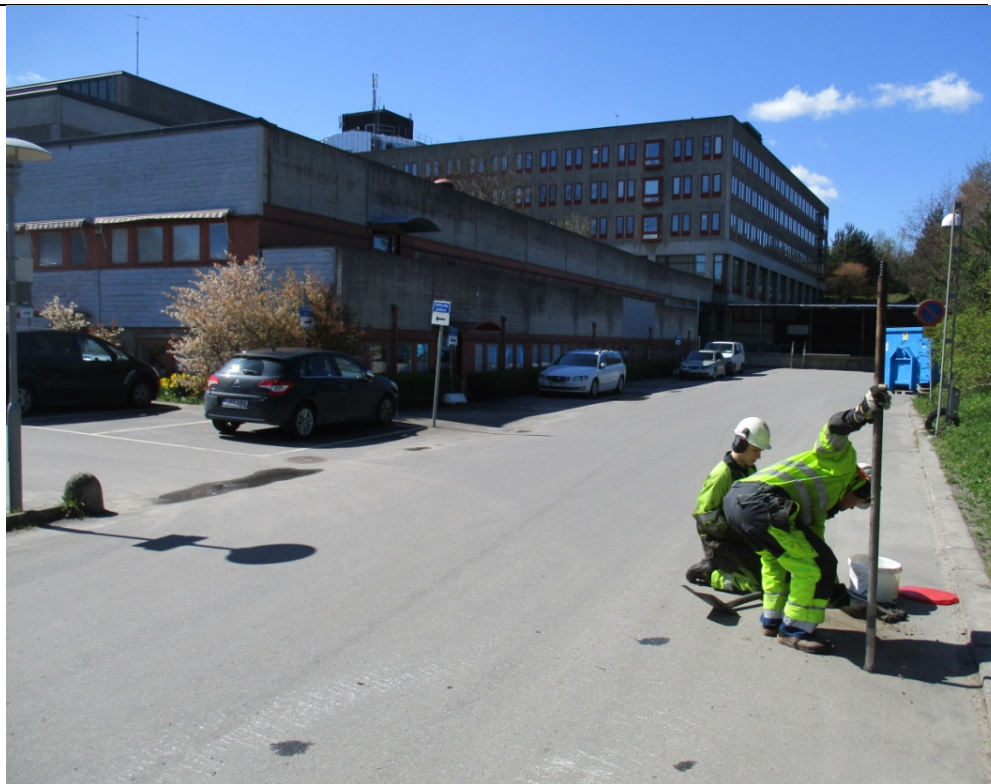
Bild 7. Lagning asfalt efter provtagning punkt S10 - Mårbacka
