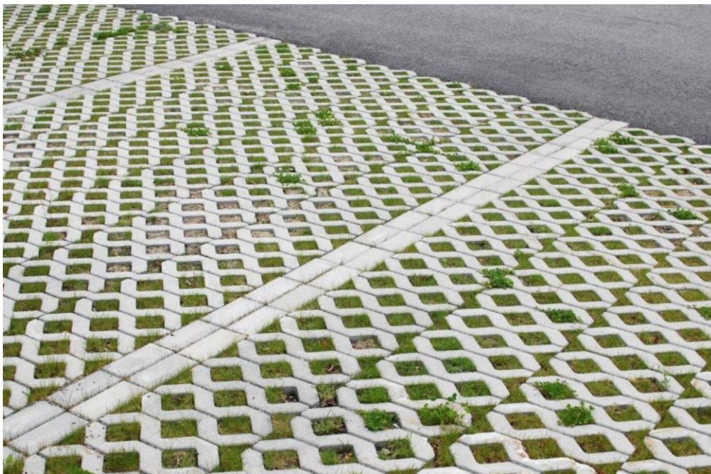
Figur 10: Gräsarmerad betonghålsten i Växjö. Foto: Marie Larsson, Sweco. (Vinnova, 2014).
