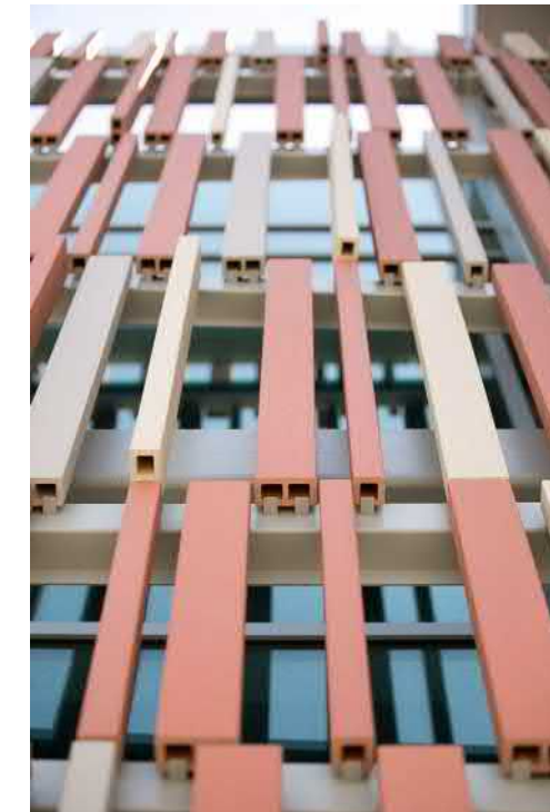
NBK TERRART Baguette montering detalj
