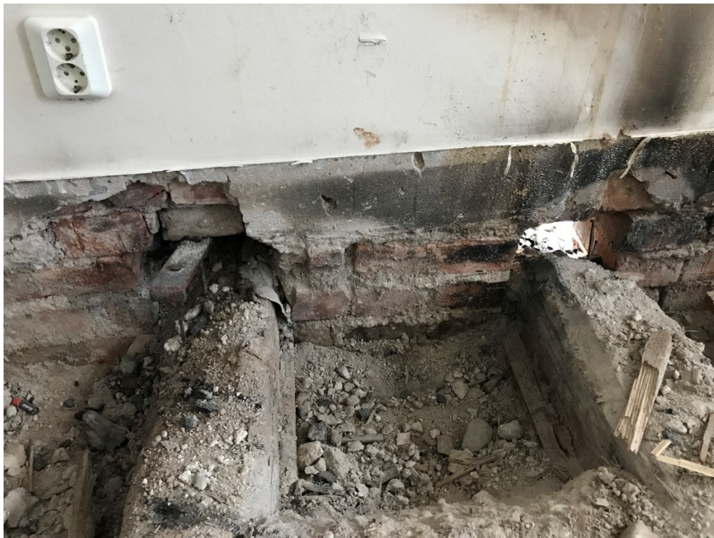
Figur 4 Träbjälkar i bostadsdelen på plan 2. Bild tagen 2018-06-14.
