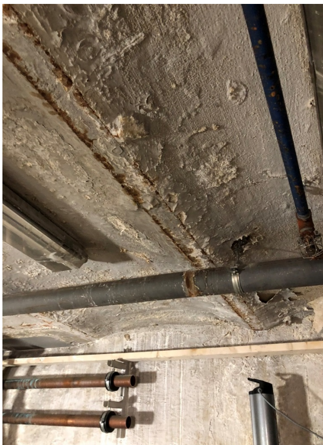
Figur 8: Rostanslag på valv under kontorsdelen. Bild tagen 2018-06-1
