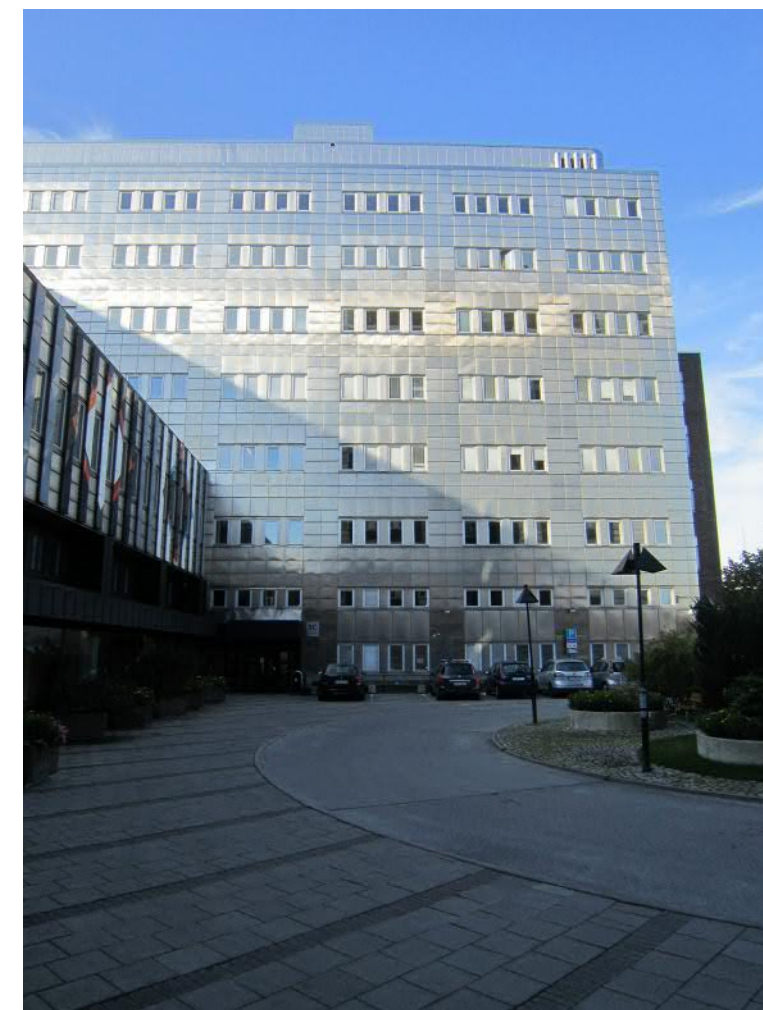
L-husets fasader mot kvarterets inre är helt klädda med kassetter i rostfritt stål.
