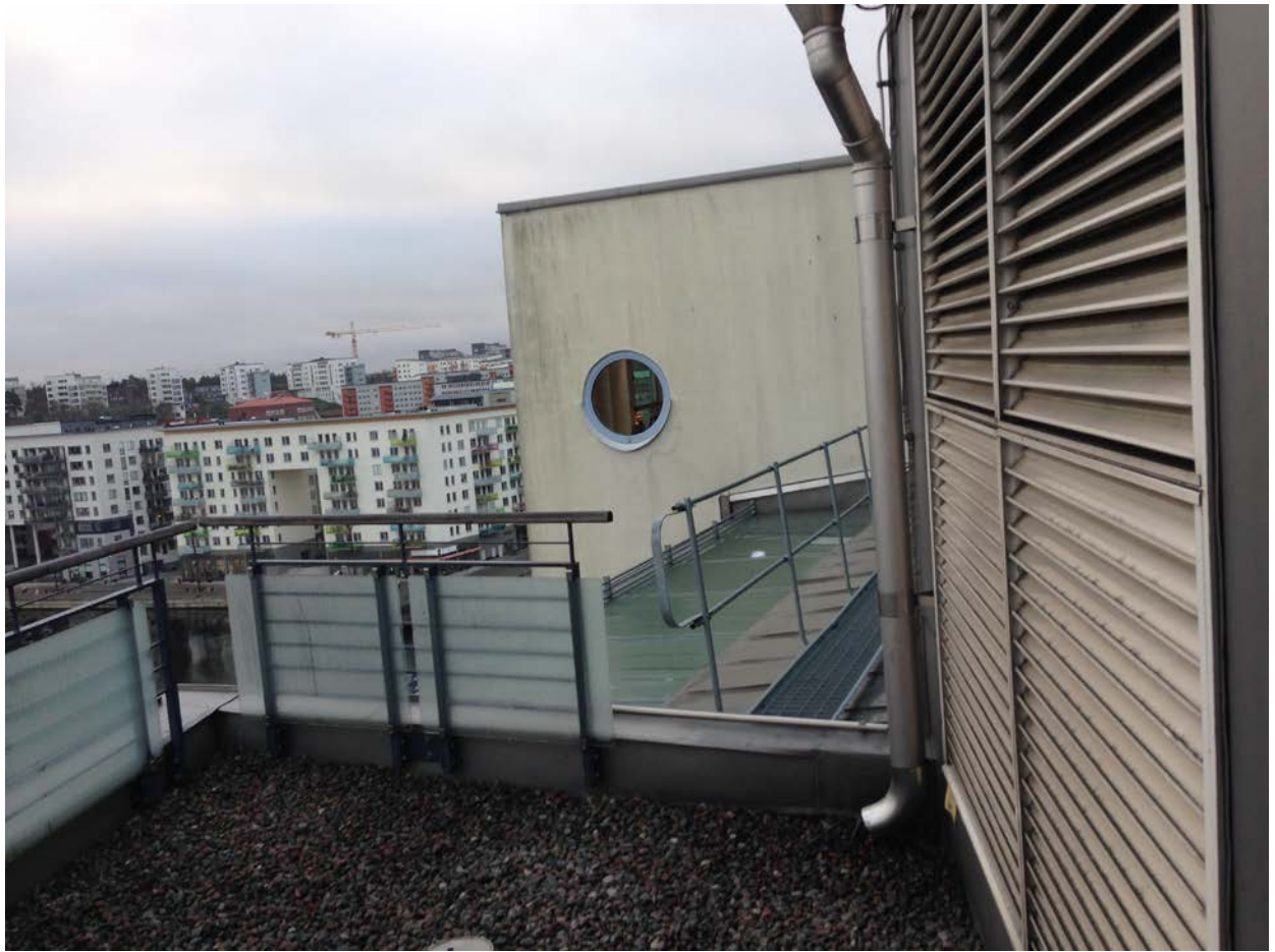
Figur 18: M28. Tilluftintag på södra delen av huset. Vy åt västsydväst
