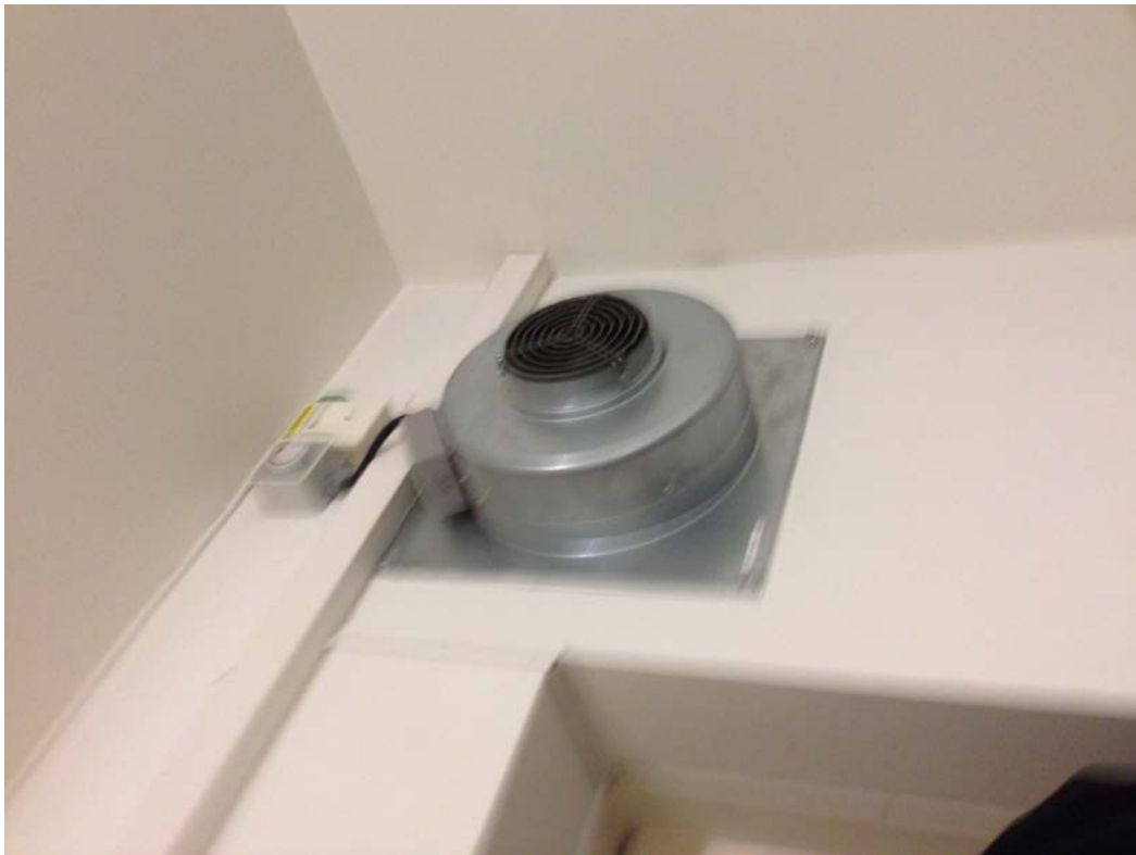
Figur 6: M23. Trapphusventilationsfläkt inifrån östra trapphuset.
