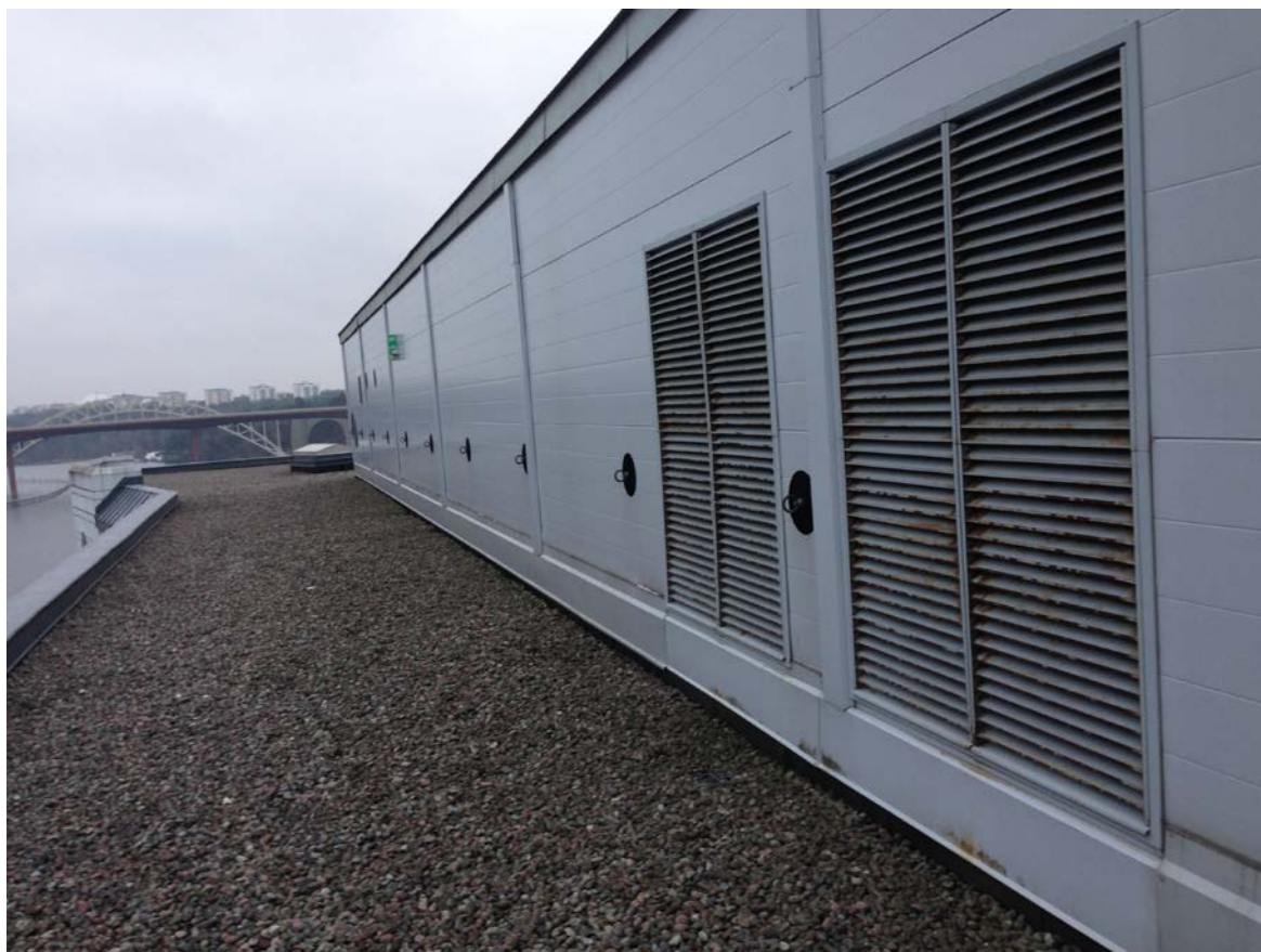
Figur 12: M25. Tilluftintag i östra delen av byggnaden. Vy söderut.
