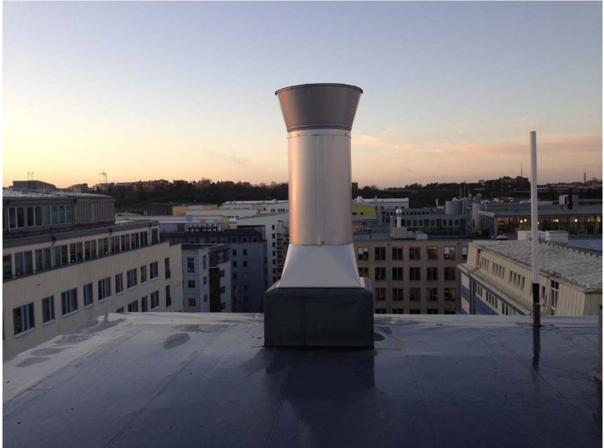
Figur 2: M19. Avluftstorn i sydvästra hörnet av byggnaden. Vy västerut.
