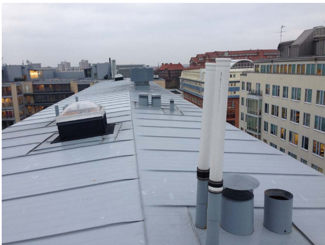
Figur 13: M25. Installationer på tak. Längs högersidan syns uppmätta objekt, från närmast i bild: Frånluftutblås, avluftutblås, rökgaskanal. Vy norrut.
