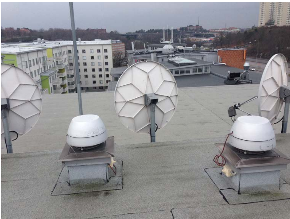
Figur 16: M26. Hissrumsventilationsfläktar i västra delen av byggnaden. Vy västerut.
