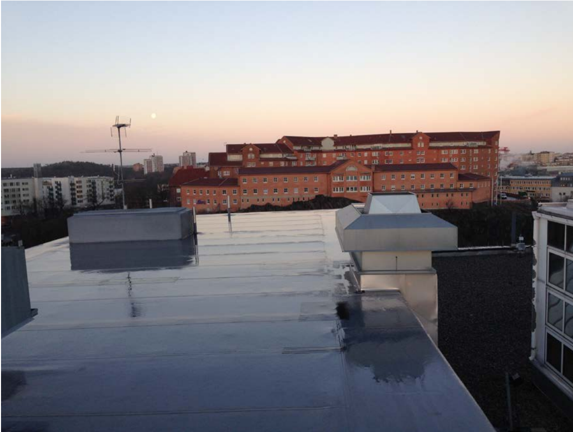
Figur 1: M19. Avluftsutblås samt Avluftstorn med huv i nordvästra delen av byggnaden. Vy norrut
