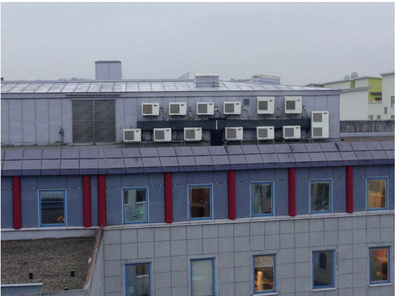
Figur 9: M24. Tilluftintag med AC-aggregat på östra delen av byggnaden. Vy västerut
