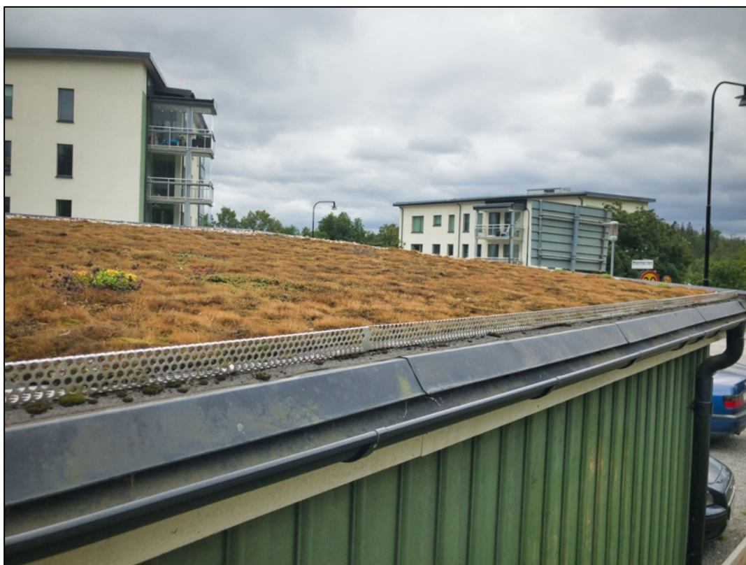
Figur 11. Grönt tak på ett garage. Foto Geoveta.
