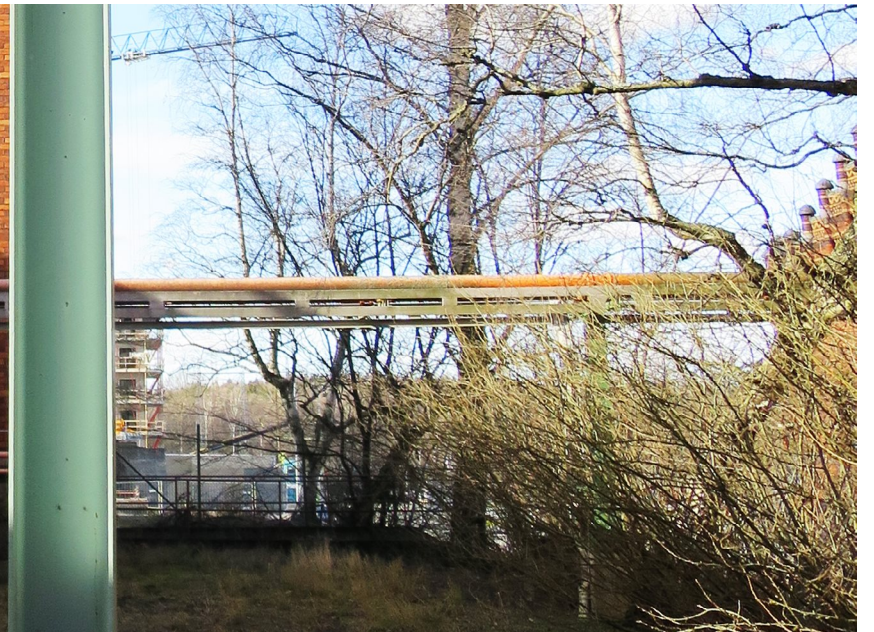
Vy 48. ledningsstråket mellan hus 7 och 9 tar sin början till vänster i bild och stöds av två stålstolpar.
