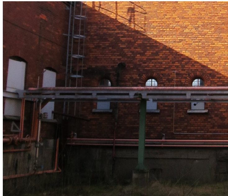
Vy 48. ledningsstråket mellan hus 7 och 9 tar sin början till vänster i bild och stöds av två stålstolpar.
