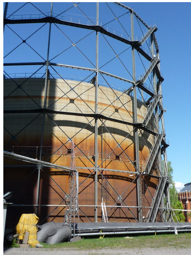
Vy 44. Gasledningen i anslutning till gasklocka 3.
