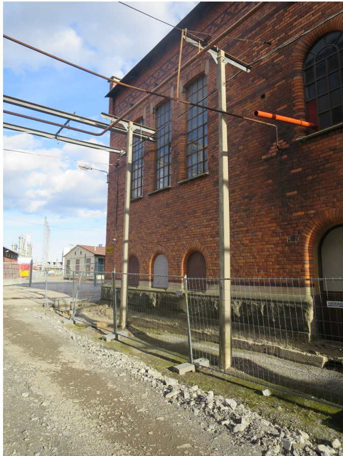
Vy 5. Norra ledningsstråket böjer av och ledningarna leds längs norra fasaden hus 10.
