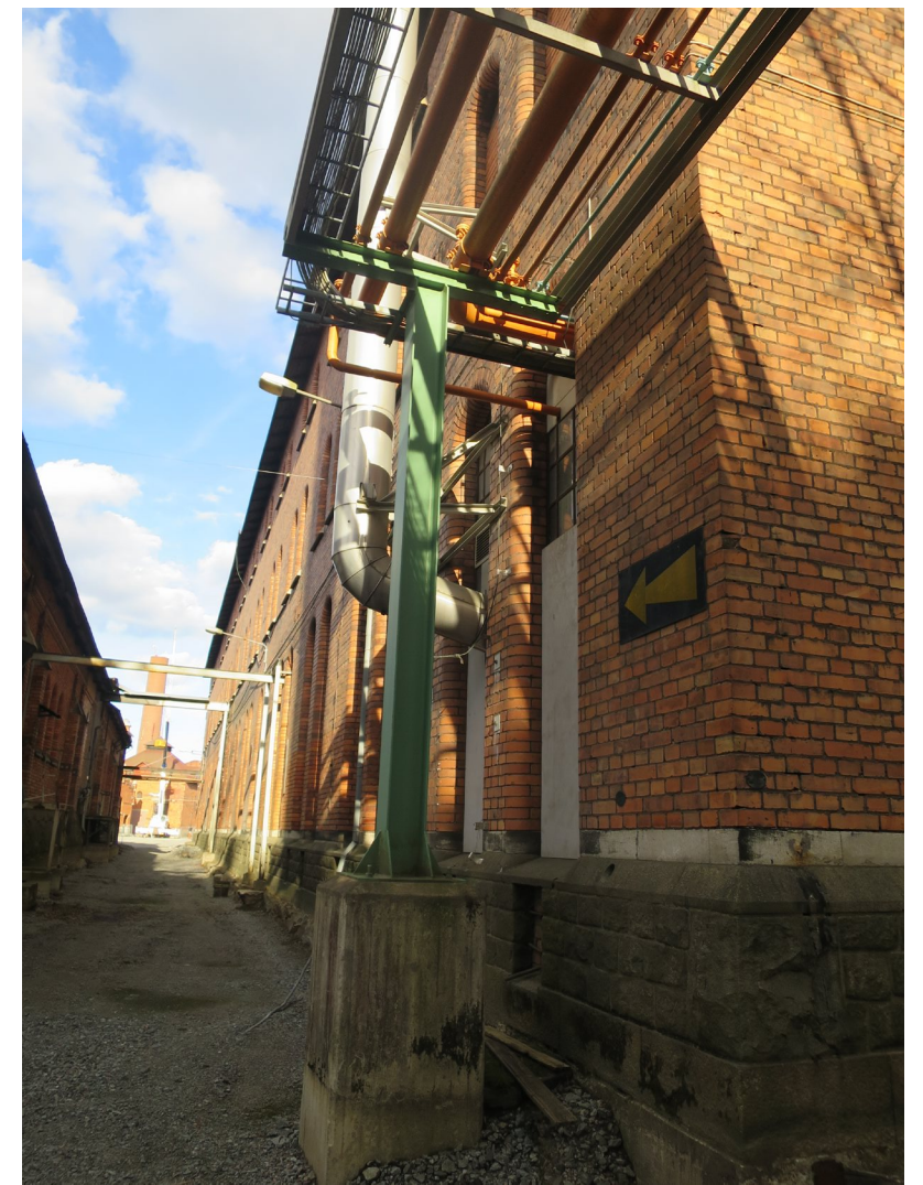
Vy 50. Luftledning på konsol och stolpe av stål vid hus 9.
