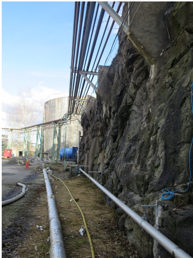
Vy 33. Södra ledningsstråket på konsoler längs bergsskärningen.
