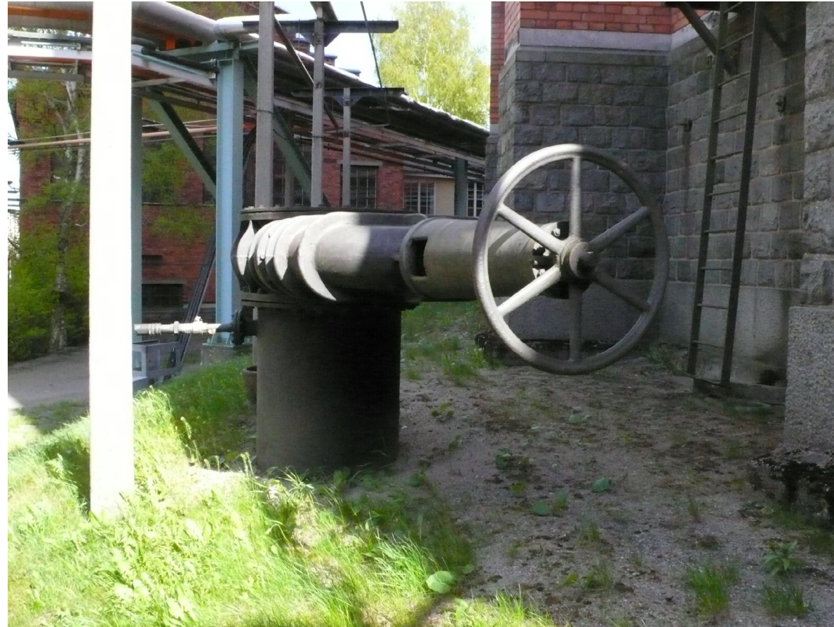
Vy 38. Gaskran D vid gasklocka 2.
