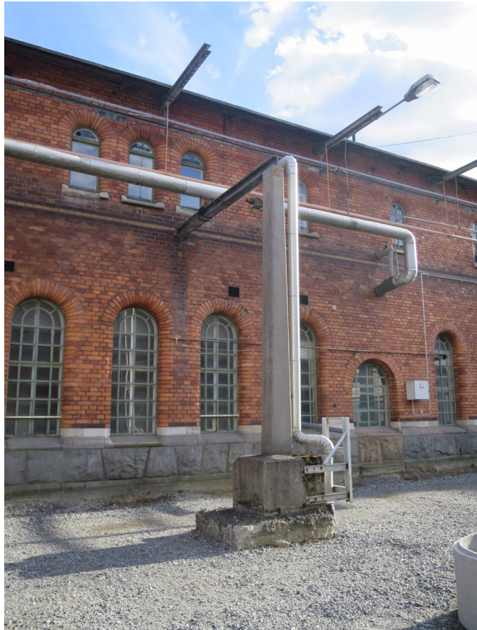
Vy 8. Kraftigare stolpe, till sin utformning, avvikande från de ursprungliga smäckra stolparna - en av tre.
