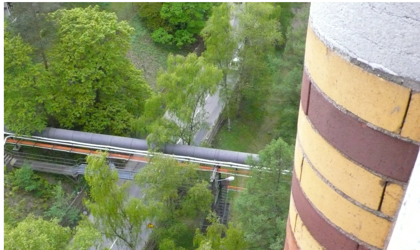
Vy 46. Gasledningen med gångbrygga över Gasverksvägen.
