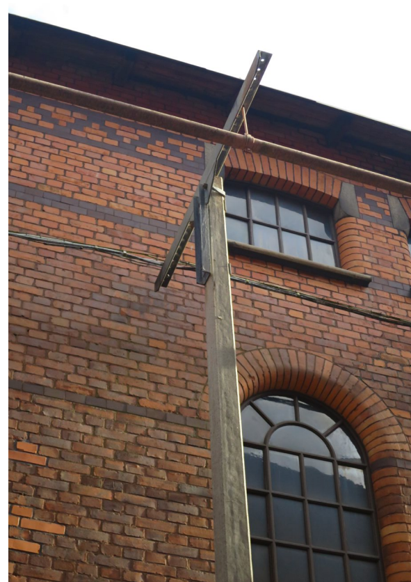
Vy 3. Betongstolpe med konsol och ledning.
