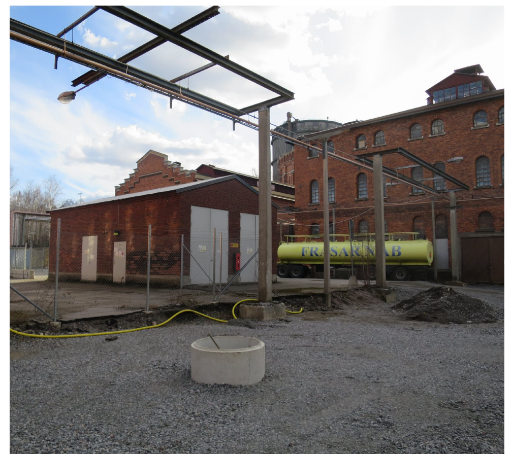
Vy 7. Stållamar på grövre betongstolpar mellan hus 14 och 9.
