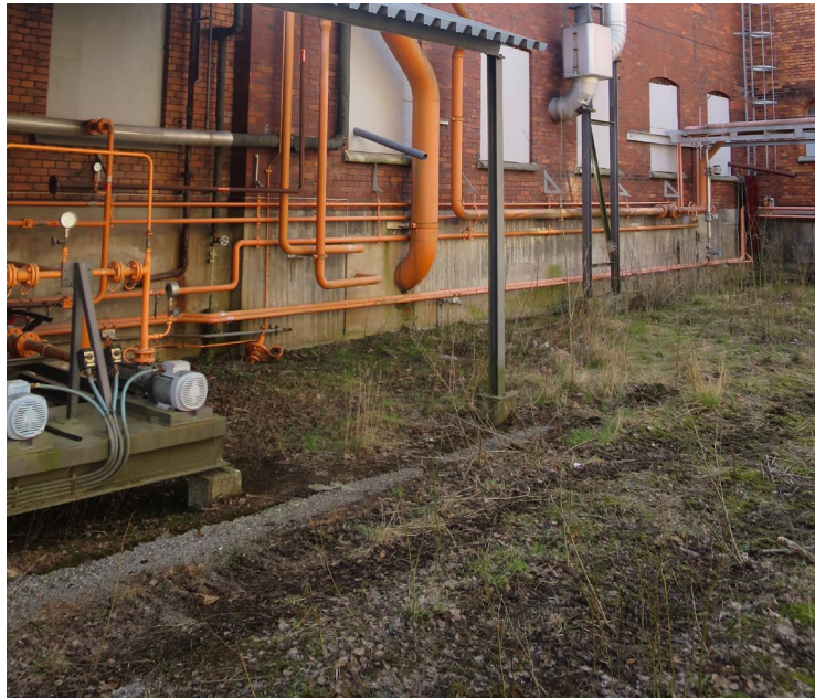
Vy 47. Mellandelen av hus 7 är utrustad med ledningar och kopplingar som är förbundna såväl med Södra ledningsstråket som med ledningsstråket mellan hus 7 och 9.
